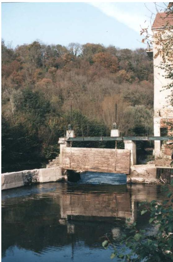
En 1770, Trésaguet, chargé par Turgot de canaliser la Charente "à l'économie" remplace la traditionnelle porte démontable par une porte "déshabillable" :
