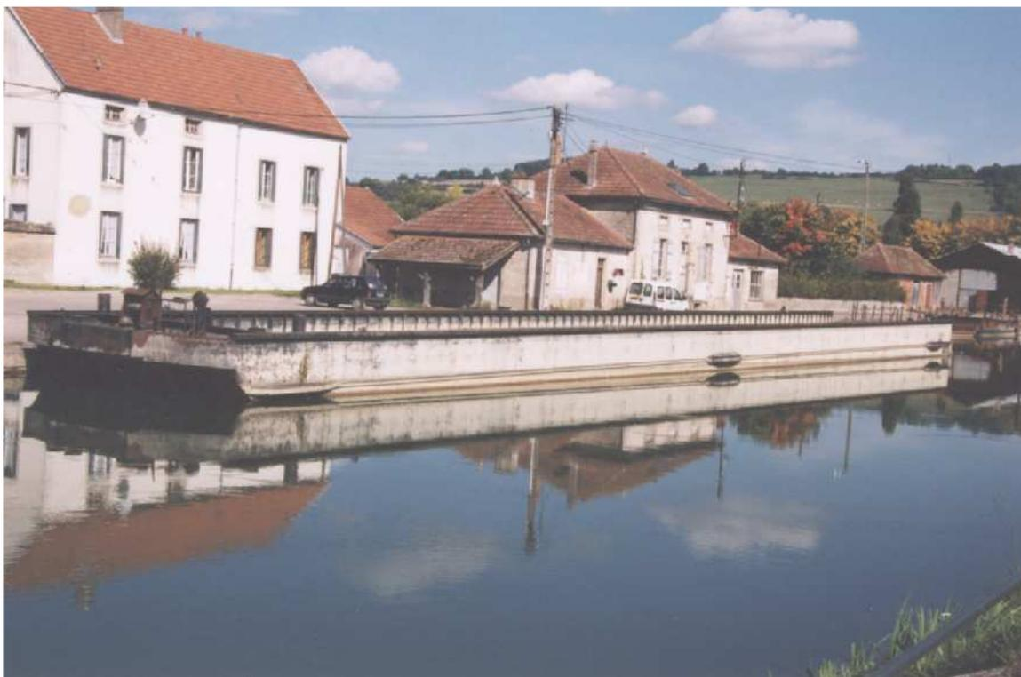
*Dans ce bac (1910) on coulait les péniches en vidange pour le passage du souterrain de Pouilly (F-21) Canal de Bourgogne*
