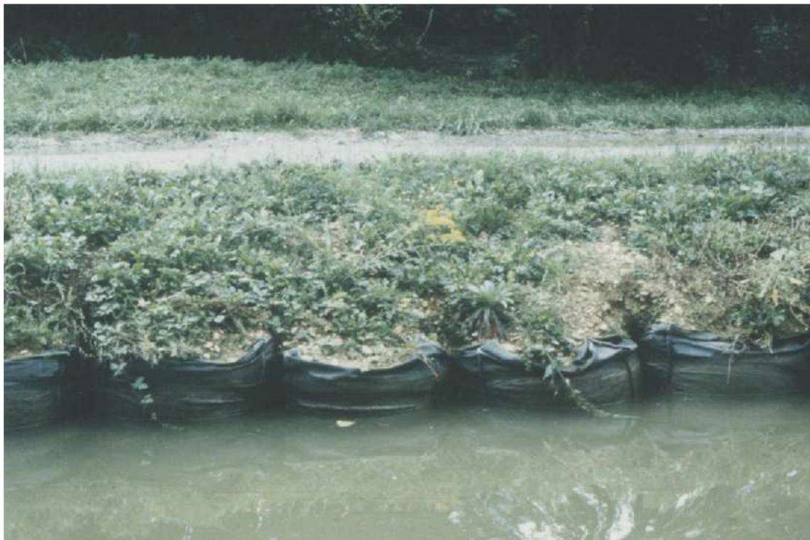
*Sacs de sable (et un peu de ciment) peuvent conforter une rive. C'est particulièrement inesthétique. Bief de partage du Rhône au Rhin (F-58).*
