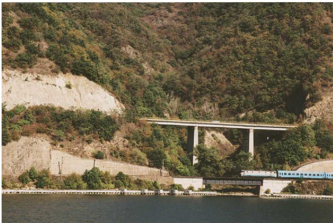
*Quand on élève un barrage, il faut créer des voies ferrées, des routes, des tunnels à un niveau supérieur. Défilé des portes de fer. Danube (Ro).*
