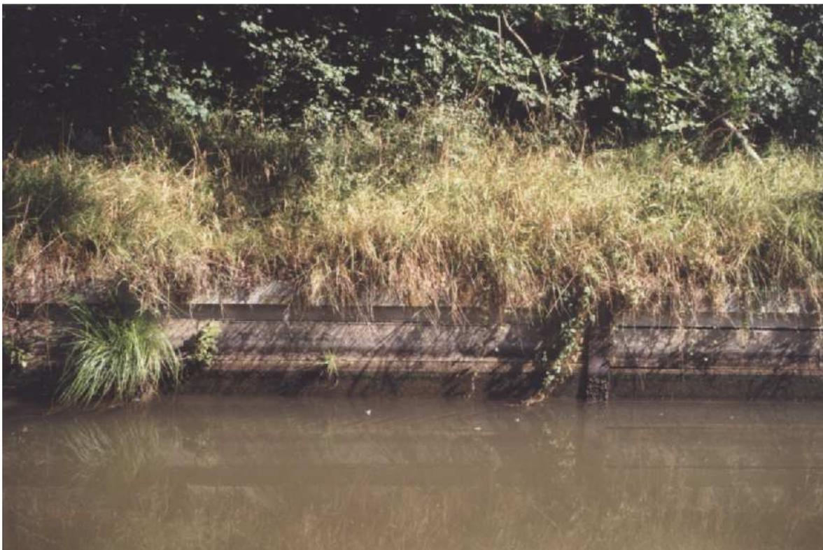
*Ou des plaques de béton sommées d'un basting (Canal de l'Est)*
