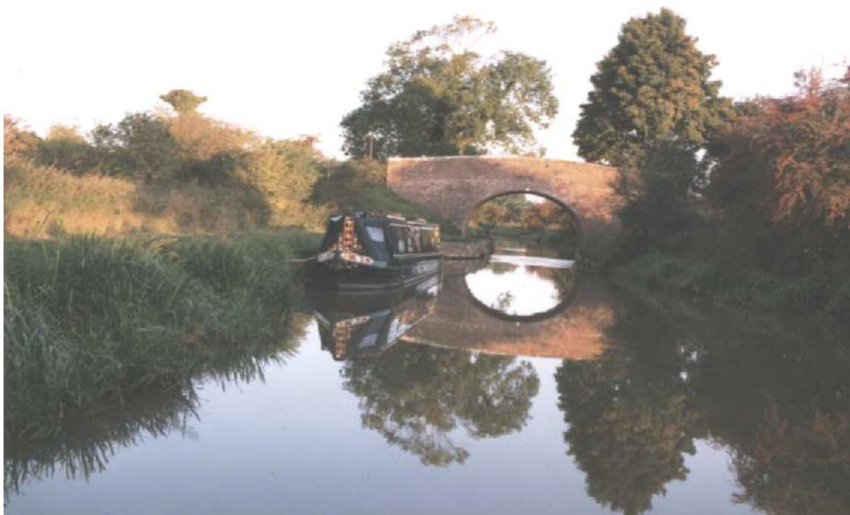
*Ces ponts de briques permettaient aux chevaux de changer de rive. Kennet & Avon canal (GB).*
