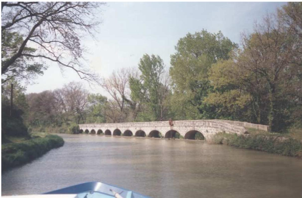
*Sur le canal du Midi, les chevaux franchissaient l'épanchoir d'Argent Double (F-11) sur un long pont.*
