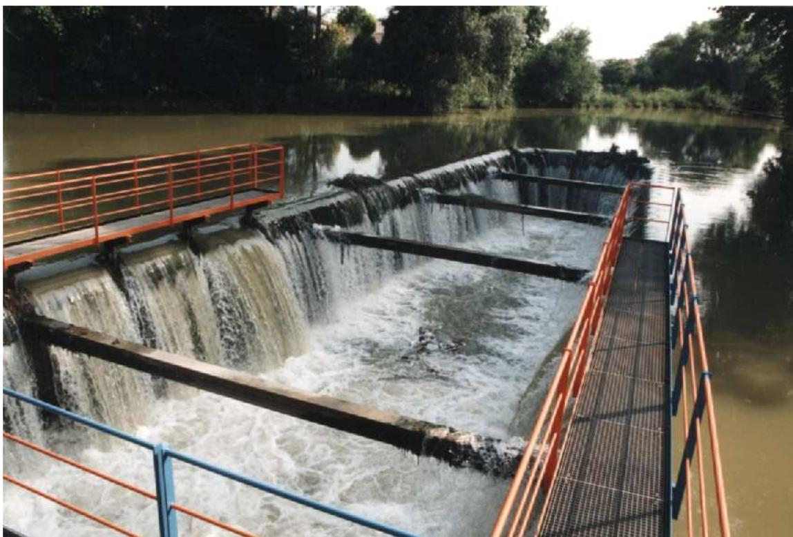
*Un déversoir complexe sur le canal de Saint Martin le pré (F-51). L'eau passe sous le canal latéral de la Marne et se déverse dans la Marne. On a allongé au maximum les lignes de déversement pour éviter les remous.*
