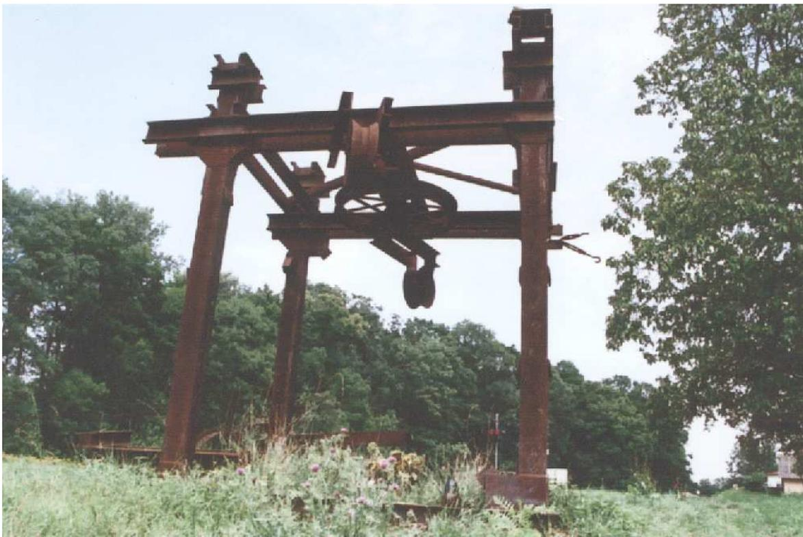
*Portique garni de poulies et de crochets pour aider les manœuvres de franchissement de la Morava, aux écluses de Staznice. Canal Bata. CZ.*
