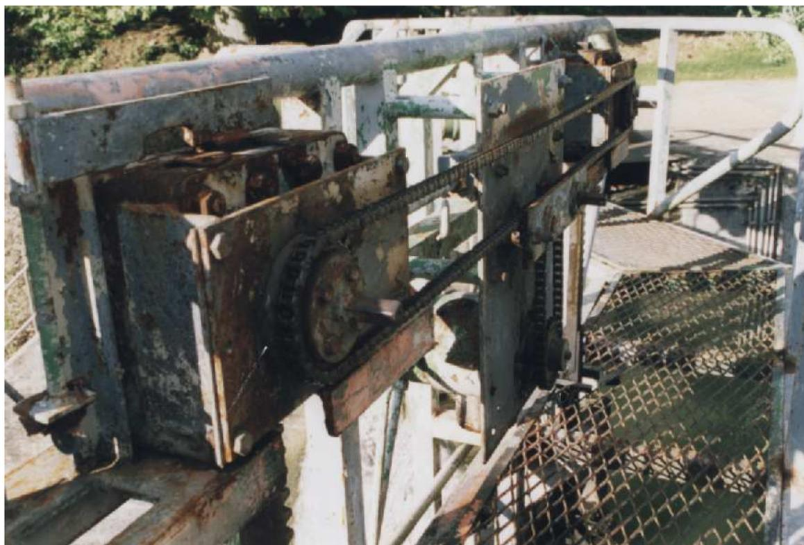
*Ouverture simultanée des vantelles de l'écluse de Castet en Dorthe (F-33), canal de la Garonne.*
