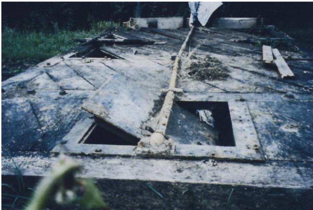
*Vantelles pivotantes, déposées, sur le canal du Rhône au Rhin.*
