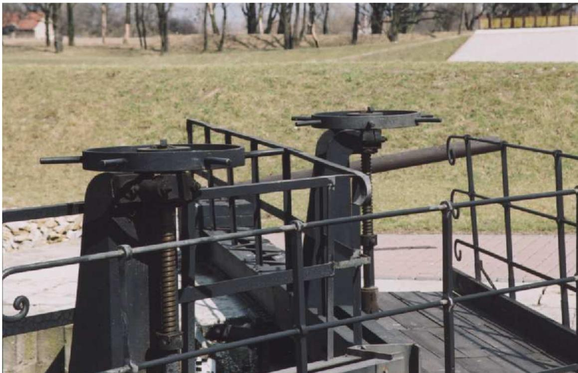
*Une vis, mue par un volant, monte ou descend les vantelles, à Kolze, sur l'Oder (PL).*
