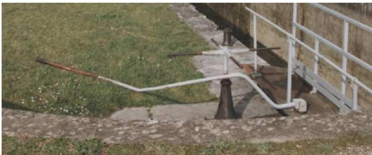
*Sur le canal du Rhône au Rhin., un tube plus ou moins coudé permet de manœuvrer ces vantelles pivotantes depuis la rive. Ecluse de Thoraise (F-25)*
