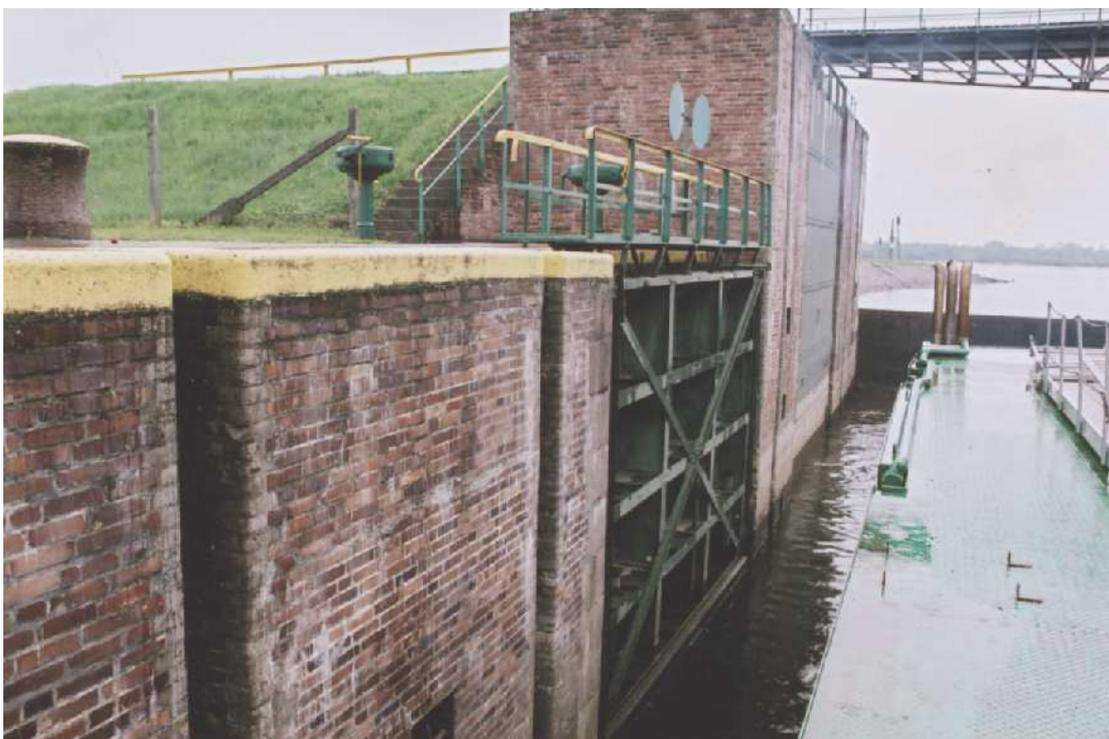
*Trois portes aval à l'écluse Gdanska Glova, canal Skarpawa (PL) : le vantail de la porte classique, la haute porte verte anti crue, la porte segment ajoutée en 2005 pour les paquebots.*
