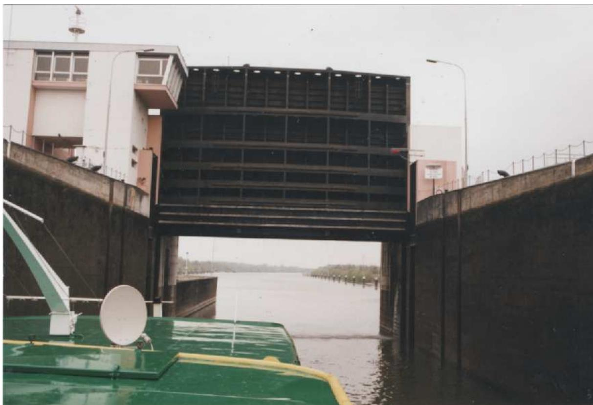
*Sur le Rhin, à l'écluse de Gambsheim, la partie supérieure de la porte aval n'est pas maintenue dans des coulisses (F-67).*
