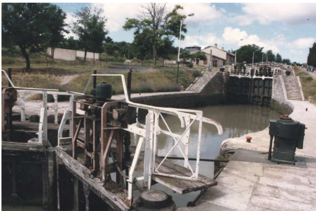
Le site de Fonsérannes illustre toute l'histoire des élévateurs à bateau : à côté de l'escalier d'eau ruisselant des 7 écluses du canal du Midi (1680), une machine de 1983 fait avancer une bulle d'eau où navigue un bateau.
