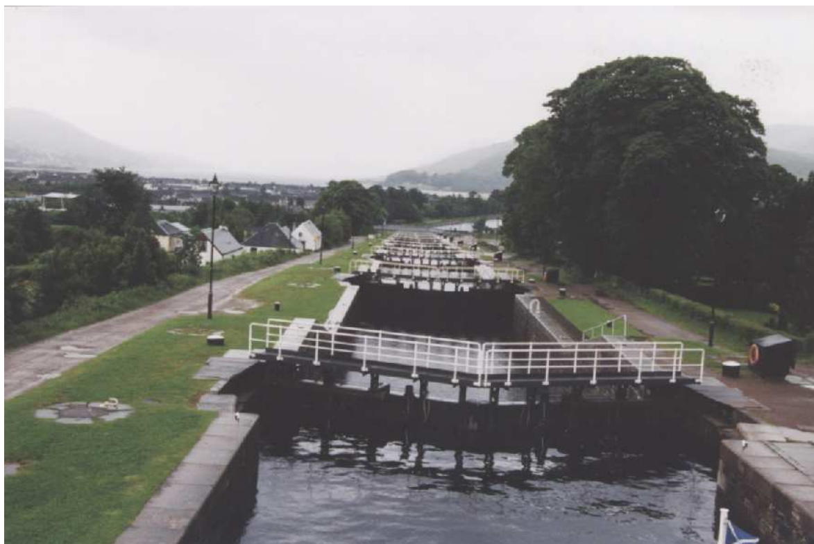
Descente de l' « échelle de Neptune » Caledonian canal –Ecosse.
