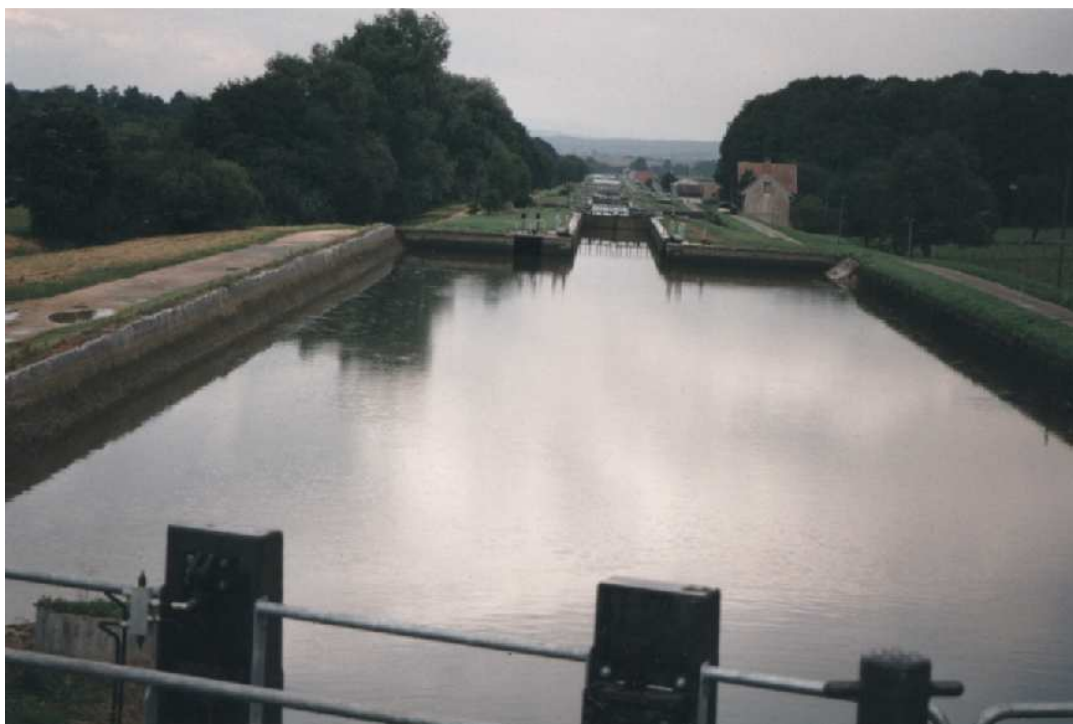
Une échelle à écluses espacées : le Valdieu, sur le canal du Rhône au Rhin (F 68).
