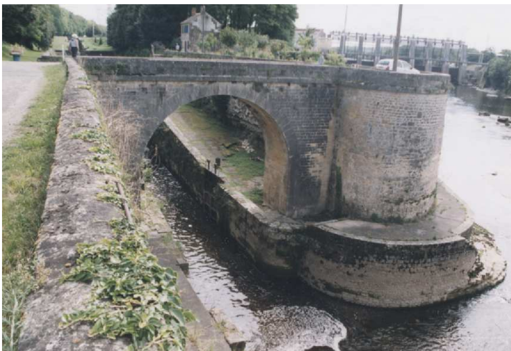
Le canal de Lalinde coupe un promontoire de la Dordogne. Son échelle de Tuilières groupe six écluses avec un bassin de virement central (F 24).
