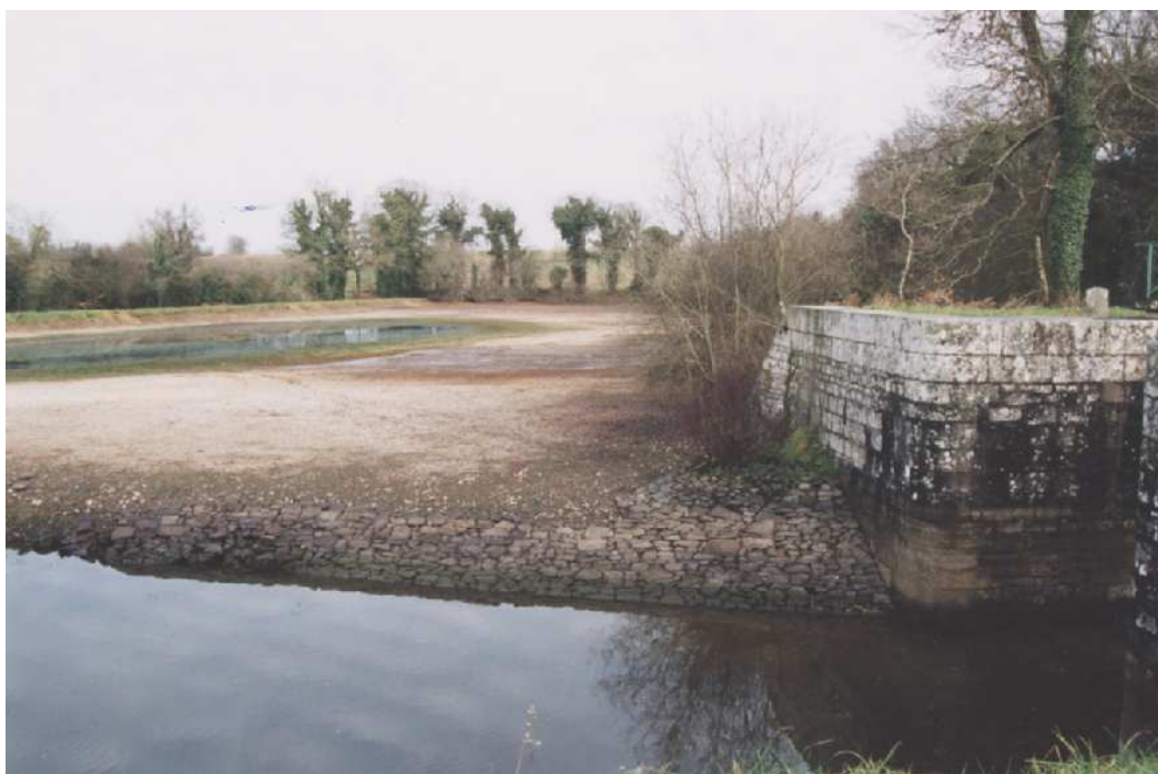
Bassin d'équilibre de l'écluse de Jolicoeur, dans l'échelle des étangs de Ros. Canal de Nantes à Brest (F 56).
