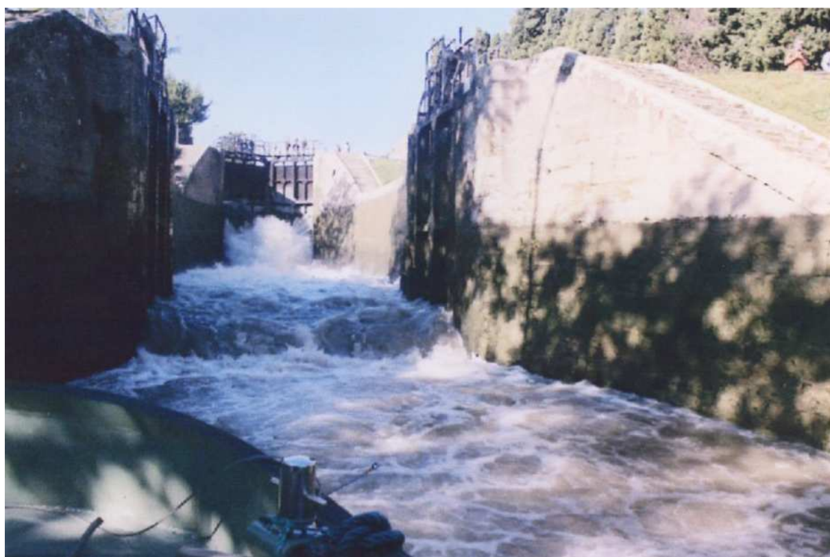
Les écluses basses de Fonsérannes. Canal du Midi (F 34).
