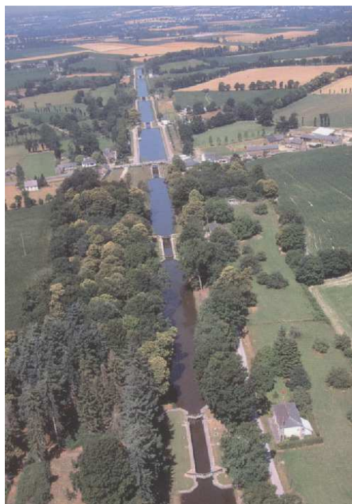
La belle échelle à écluses espacées de Hédé, sur le canal d'Ille et Rance (F 35) enfouie dans la nature, n'est bien visible que du ciel.
