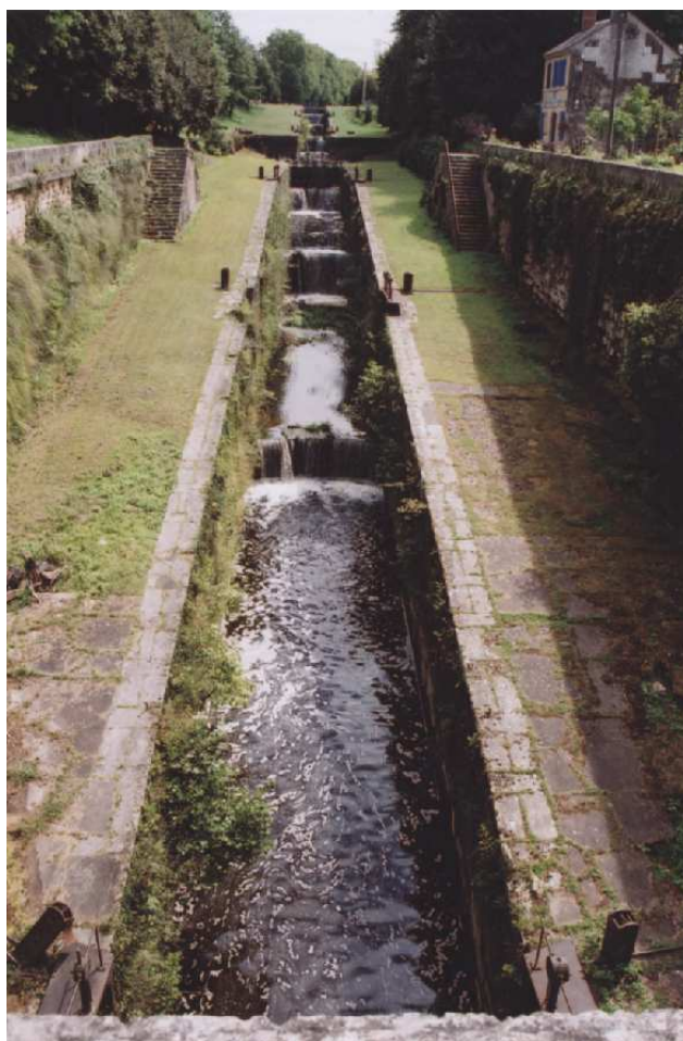
Le canal de Lalinde coupe un promontoire de la Dordogne. Son échelle de Tuilières groupe six écluses avec un bassin de virement central (F 24).
