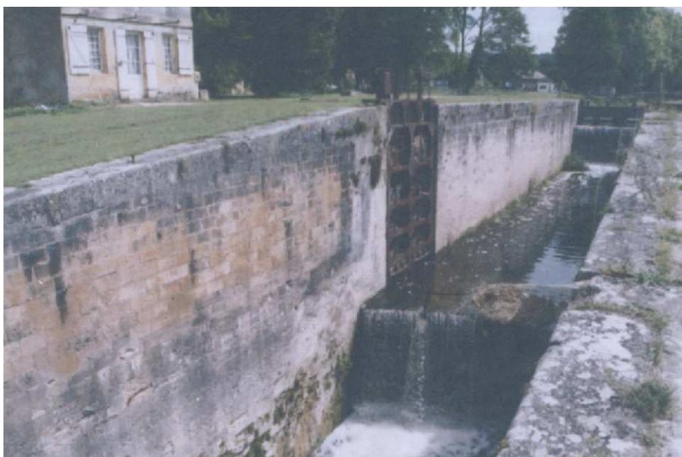
*Deux murs de chute à l'échelle de Tuillères (1840). Canal de Lalinde (F 24).*
