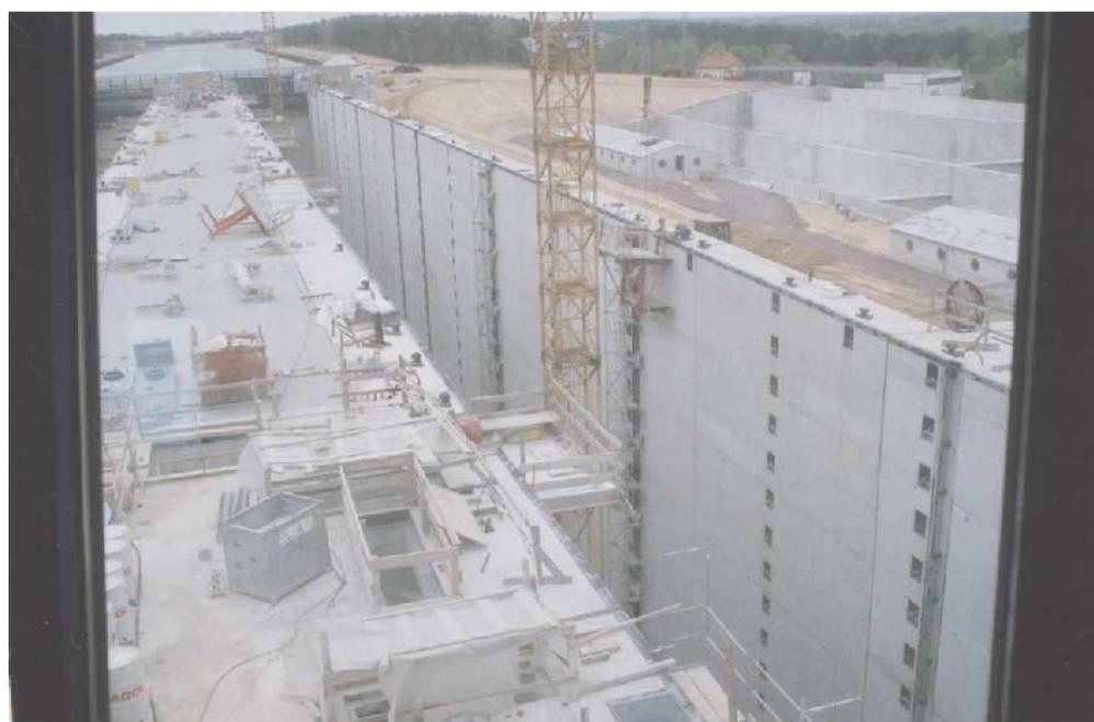
*Construction d'une des deux écluses accolées, longue de 190 m, haute de 18 m (avec trois bassins d'épargne) à Hohenwarthe sur le Mittelland Kanal (2003) vue de la tour de contrôle (D).*
