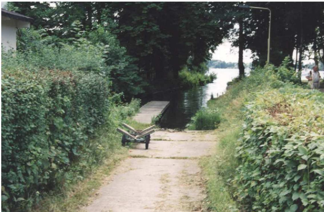
*Monte-barques à l'écluse de Wolsterdorf, sur le canal Oder Sprée (D). Ce ber à roulettes descend dans l'eau, en bas de l'écluse. On y glisse un canoë. Un plan incliné permet de le rouler jusqu'au niveau supérieur.*
