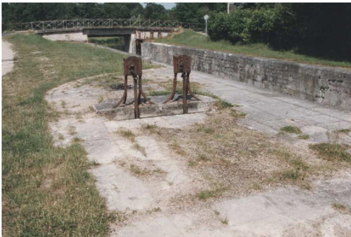
*Vannes commandant l'aqueduc souterrain partant en amont et arrivant en aval de l'écluse du Gué-Girault, sur le canal d'Orléans (F 45).*
