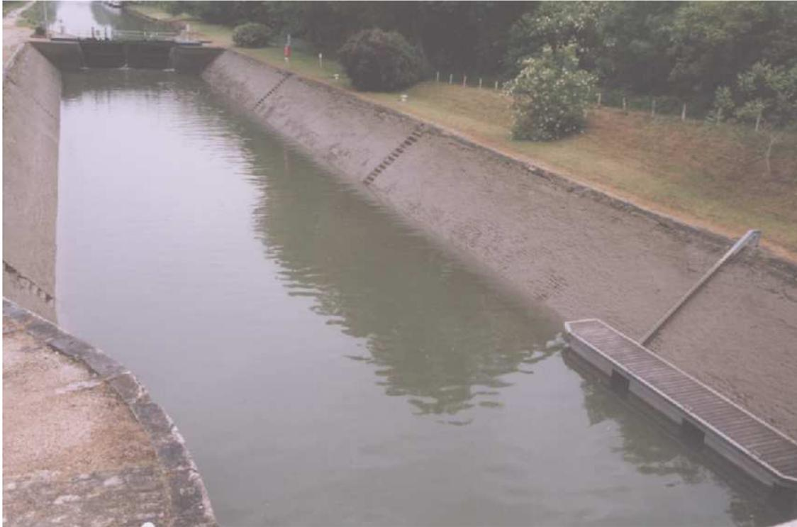
*Ecluses à perrés. Un pont flottant où des pieux d'accostage sont utiles pour amarrer un bateau dans l'écluse.*
