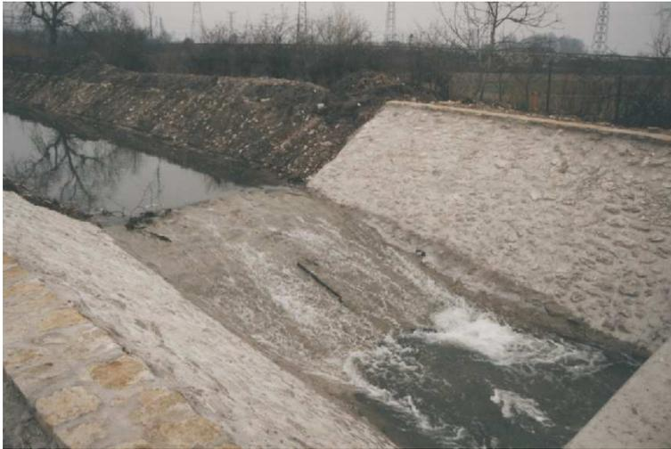
*Dans les écluses à faible dénivellation, le mur de chute est remplacé par un plan incliné : l'entonnement. Canal de Berry, écluse Saint Aubin (F 18).*
