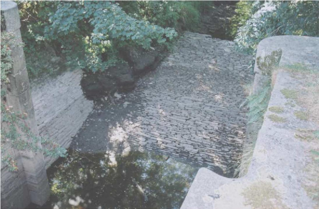
*Devant l'entrée d'une écluse, le fond du canal est pavé pour éviter les affouillements. Ecluse de Maupas à la Mézeraye, sur la Vire (F 50).*
