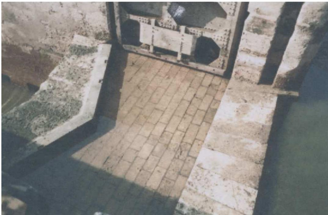
*Tête amont de l'écluse des Fées (canal de Briare – F 45). Vue d'en haut : Le radier de l'enceinte des portes est ici dallé. Généralement, le fond du canal est dallé lui aussi devant la tête amont – ou aval – de l'écluse pour éviter les affouillements. Le bas des portes vient s'appuyer sur le « busc » en forme d'accent circonflexe. La rainure (en haut à droite) est une « coulisse ». Il y a la même en face.*
