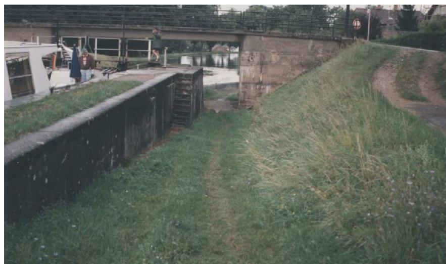
*Le chemin de halage creuse un passage entre le bajoyer et la terre ferme. Ainsi le cheval peut passer sous le pont. Canal du Rhône au Rhin. Ecluse 15 (F 25).*
