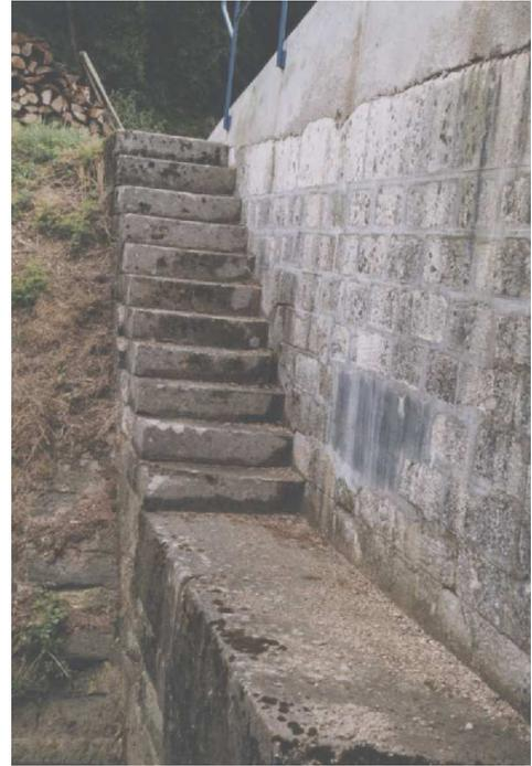
*Banquette d'abordage. Escalier du musoir : il est courbe à l'écluse de Mouzay, droit à l'écluse de Warinvaux, et courbe à l'écluse du Sep. Canal de l'Est (F 55).*
