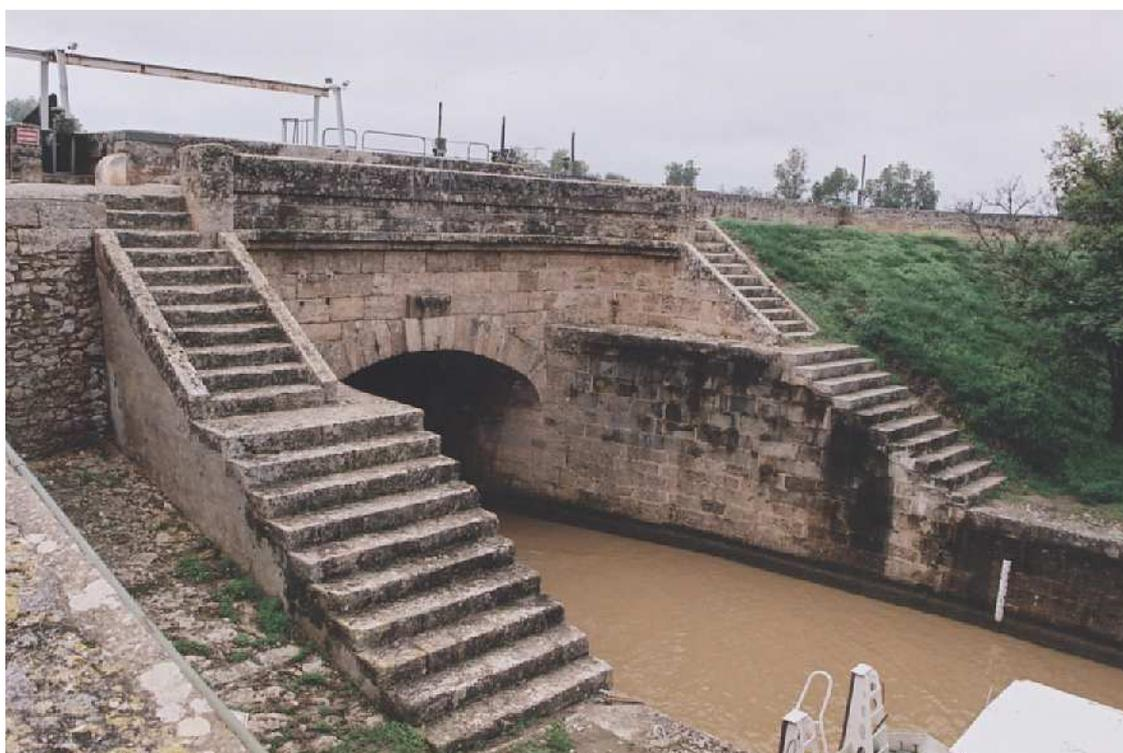
*A Moussoulens, l'écluse du canal de la Robine est protégée des crues de l'Aude par un véritable barrage (F 11).*
