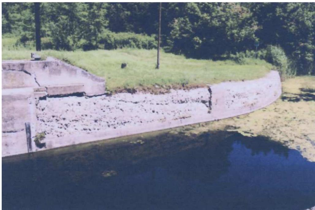
*Musoir de l'écluse de Bezdan (Serbie) construite en 1851 (par Henri Philipe Charpentier ?) sur le D T D. Ce serait la première écluse en béton.*
