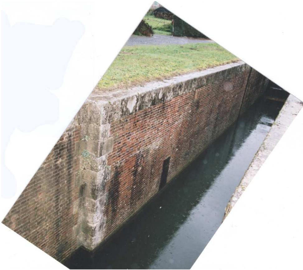
*Dans les écluses en brique, les parties fragiles (angles, couronnement...) sont renforcées par des pierres de taille – Canal de la Sauldre, écluse de Launay (F 18).*
