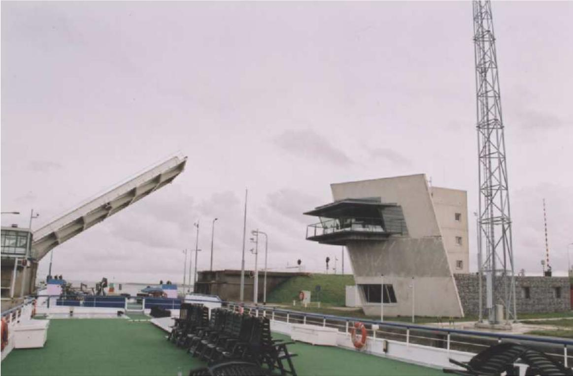
Ecluse de Kats (Zélande) Le poste de contrôle est fiché dans une planche en béton.
