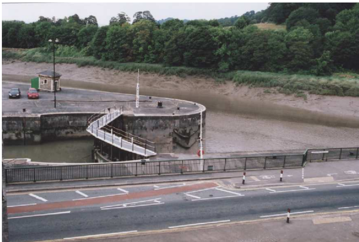
Bristol (GB) porte de marée à vantaux cintrés de Brunel.
