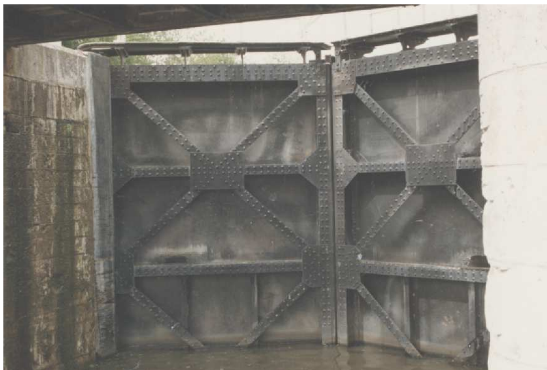
Porte rivetée – 1890 – Ecluse du moulin neuf – Canal de Briare – (F 45).
