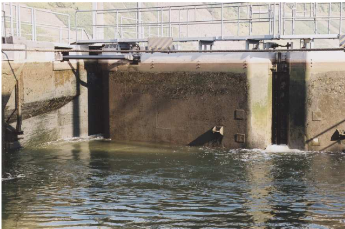
Ecluse de Frankel (D) sur la Moselle. Des jets d'eau chassent les ordures dérivantes, de chaque côté de la porte, à l'entrée du bateau et à l'ouverture.
