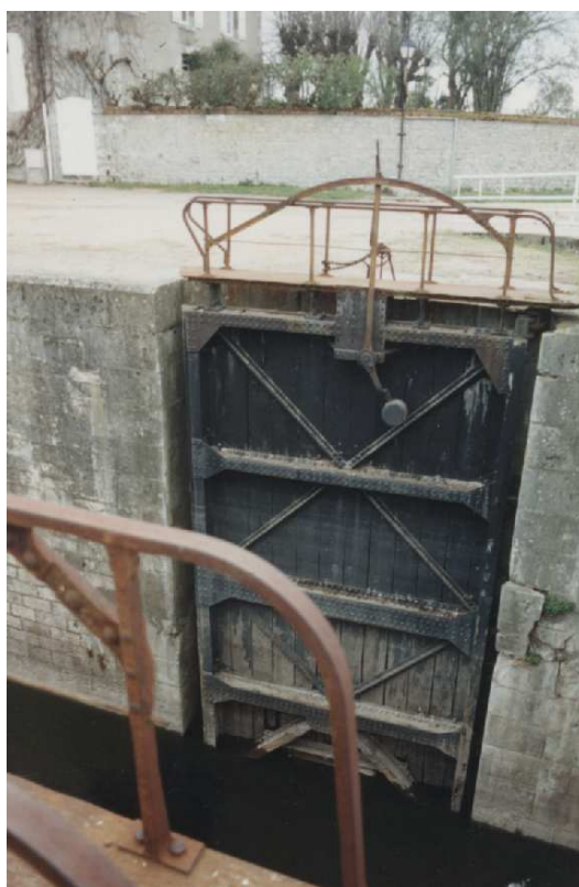
Porte fer et bois. Ecluse de Combleux. Canal d'Orléans (F 45).
