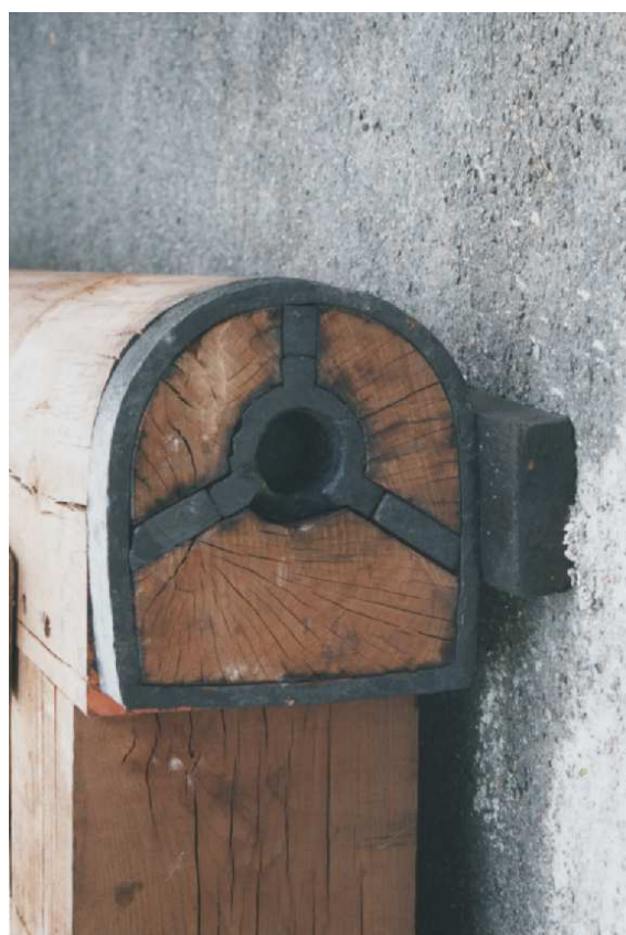
Montage de la crapaudine à la base du poteau tourillon.
