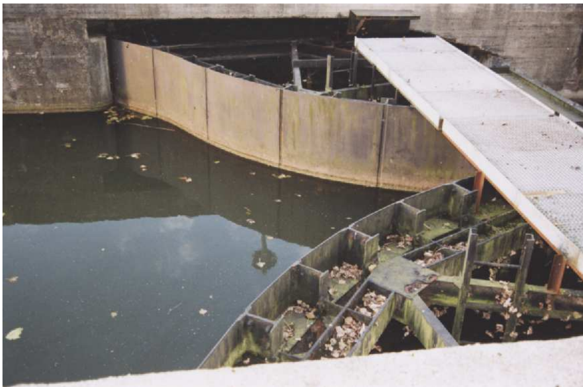
Ecluse 6 d'Armentières, sur la Lys (F 59). Porte à vantaux cintrés.
