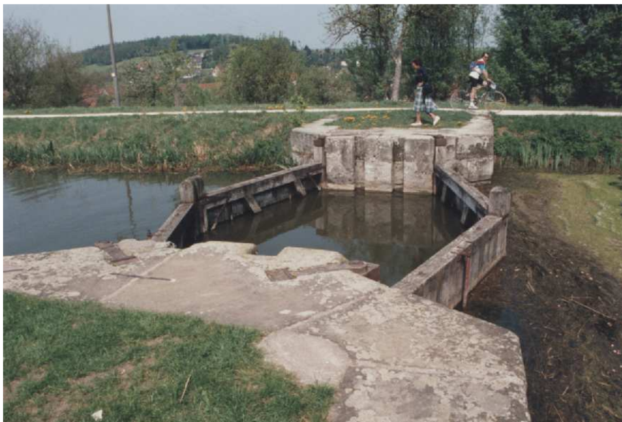
Double porte de garde. Ecluse de Schwarzenbach. Ludwig Kanal.
