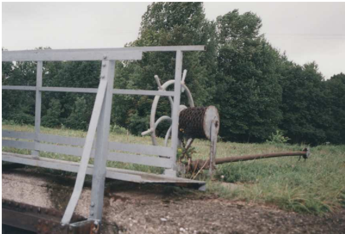
Le treuil tire la porte à la chaîne ou la repousse avec un tube à Voujeaucourt, sur le canal du Rhône au Rhin (F 25).
