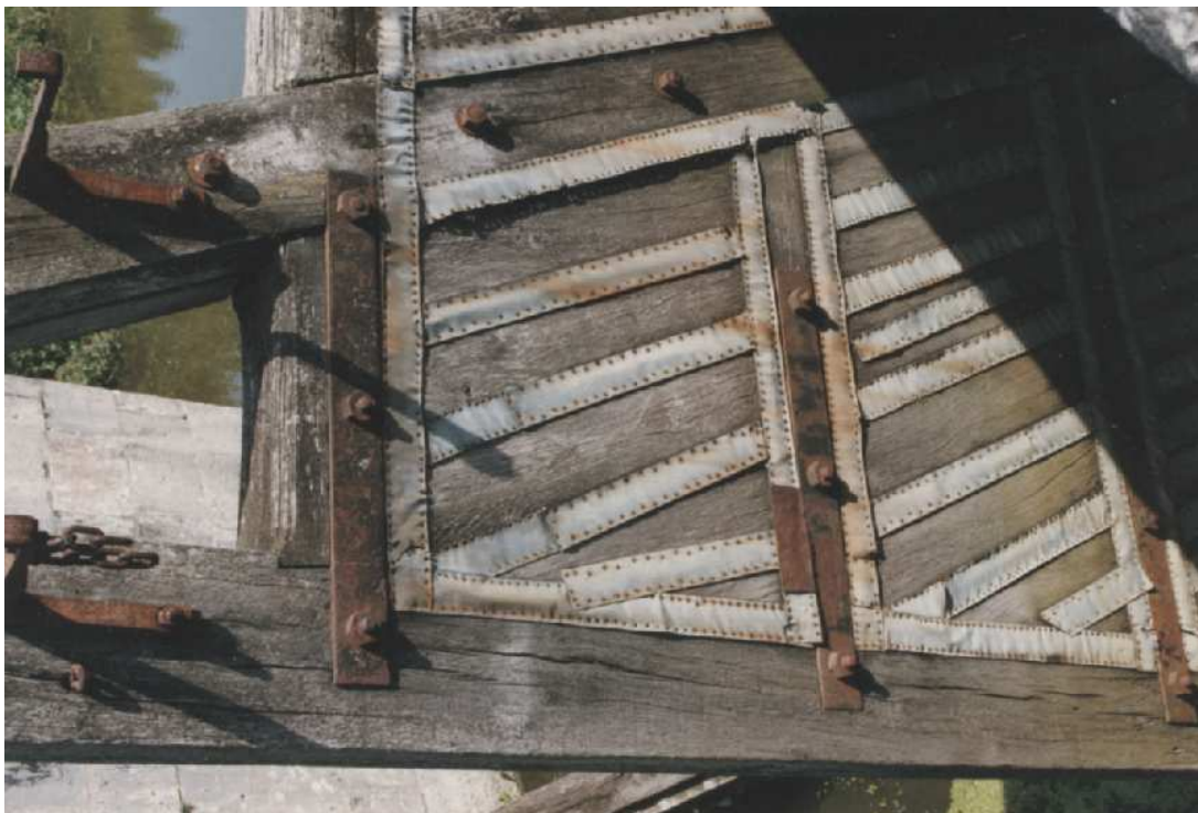
Porte calfatée avec couvre-joints. Ecluse Sainte Catherine. Canal d'Orléans (F 45).
