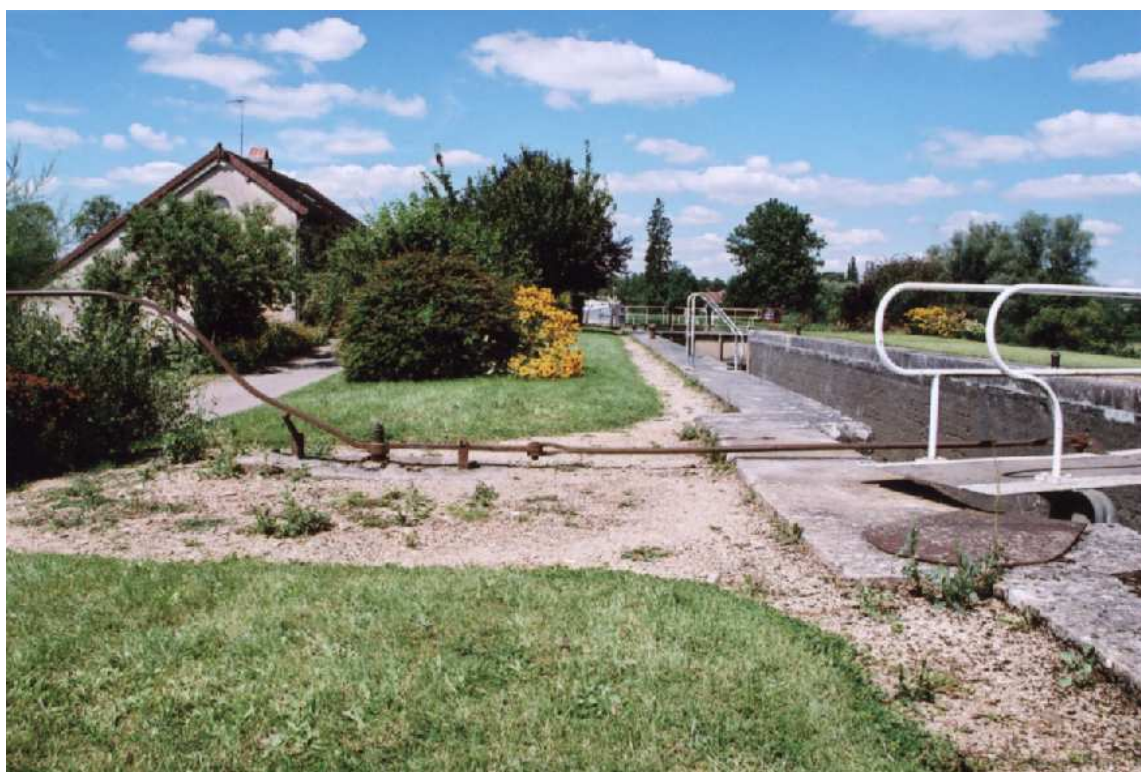
Fermeture de porte à Vandenesse (F 21) Ecluse 8 Med Canal de Bourgogne.
