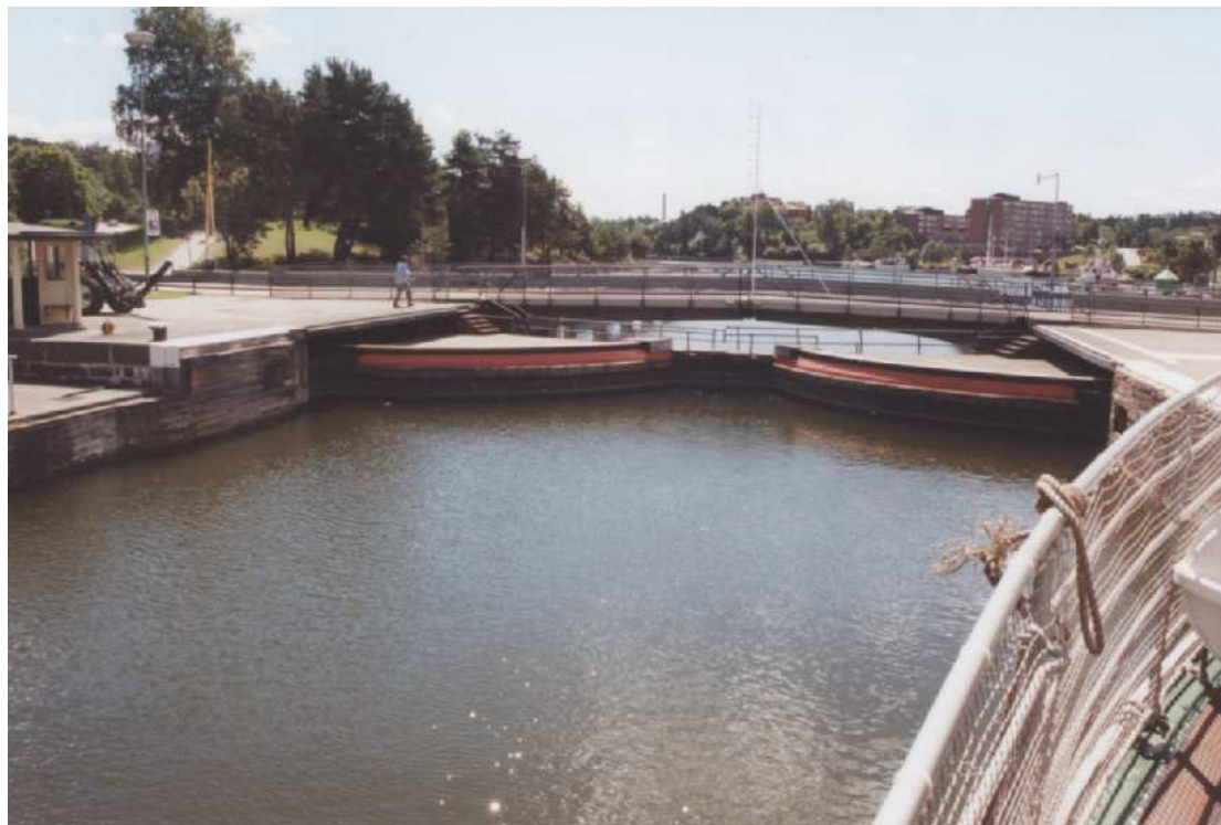
Canal de Sodertalie (Suède). Les portes « double sens » se bloquent face à l'amont ou face à l'aval, selon la marée.
