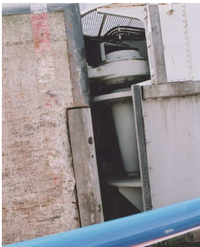
Le poteau-tourillon réglable d'une porte moderne en acier. Ecluse de Terneuzen. NL
