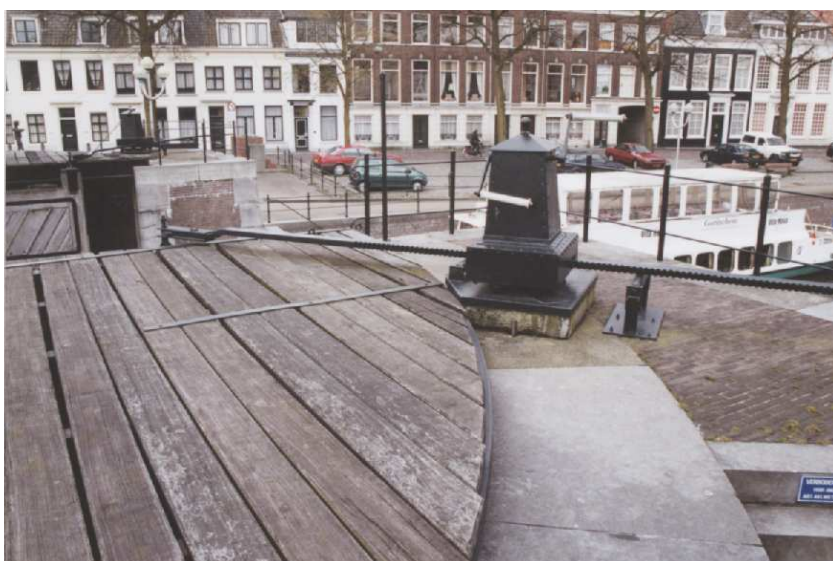
Longue crémaillère de l'écluse Korenburg sur la Linge, à Gorinchem (NL).
