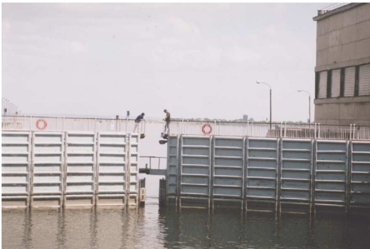
Vérification de la fermeture des portes de l'écluse de Volgograd, sur la Volga (Rus).
