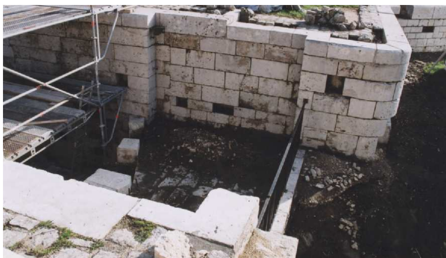
Réfection de la chambre des portes. Ecluse haute de Rogny, canal de Briare (F 89).
