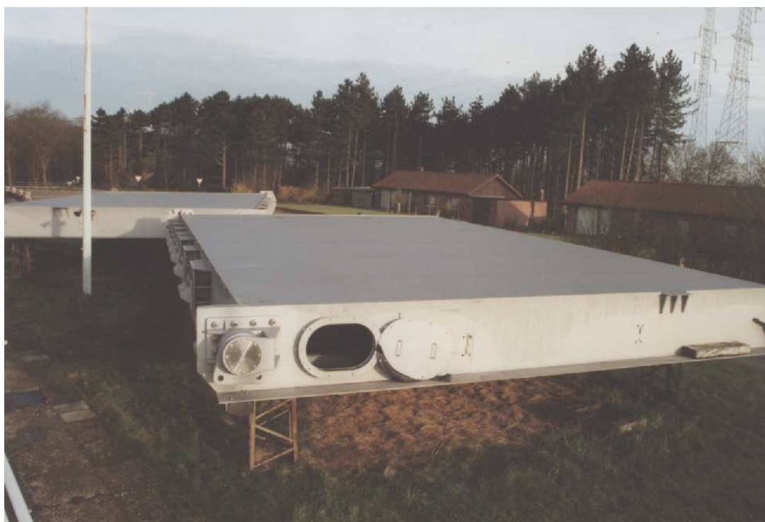
Une porte neuve. Canal Albert (B). Ecluse de Ham.
