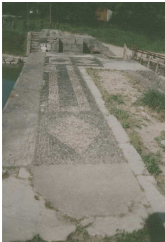
Canal de Montech. Ecluse de Montauban (F 82).
