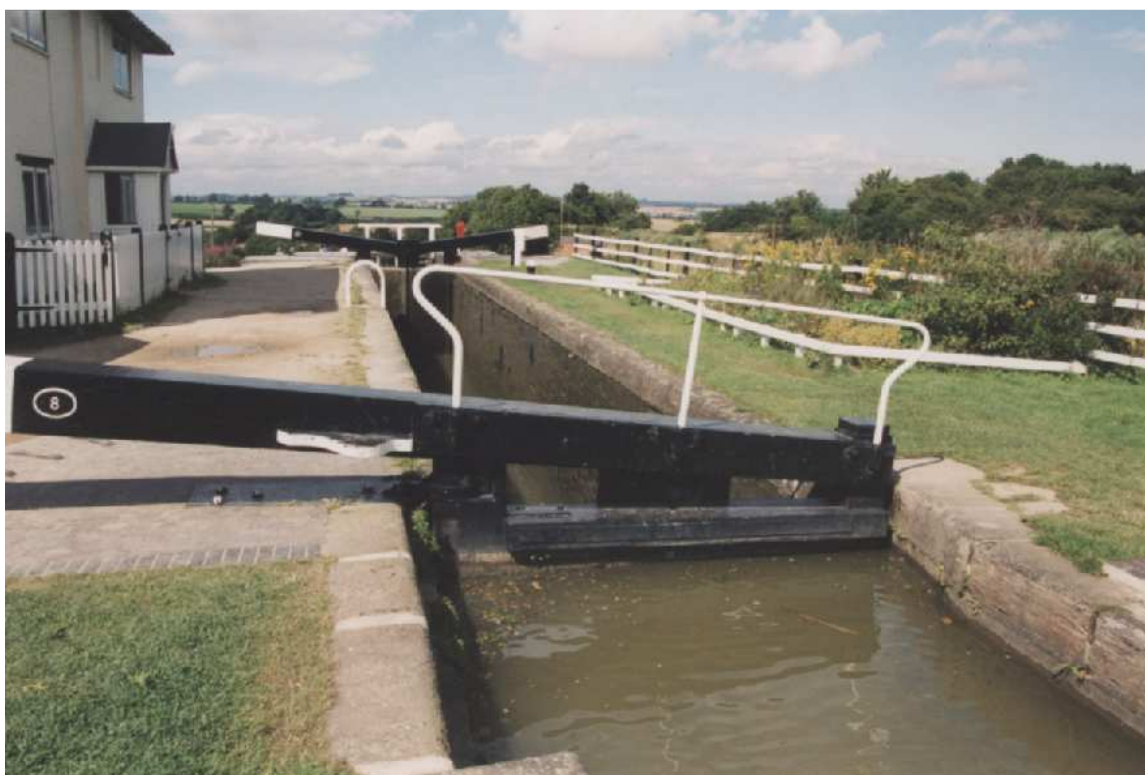
Ecluse supérieure, à un seul vantaill, de l'échelle de Foxton (Branche Leicester du Grand Junction canal) GB.
