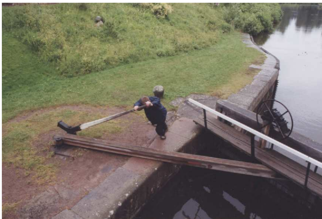
Göta canal (Suède) Cabestan de l'écluse de Tatorp.
