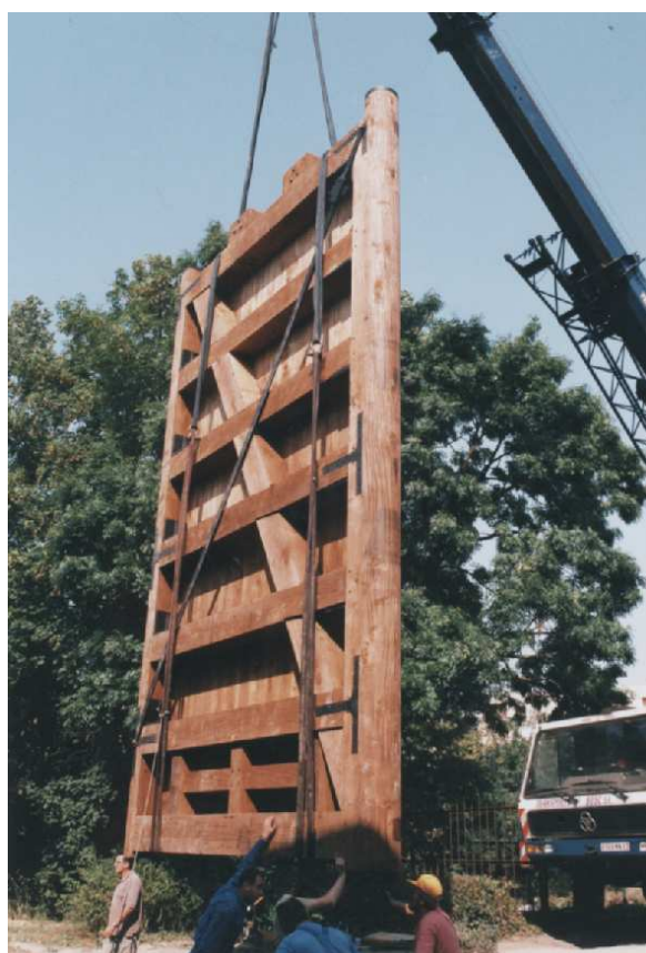
Canal Cornillon, à Meaux (F 77). On en fabrique encore (1995). Ici on a retrouvé, au fond du canal, les ferrures de l'ancienne porte.
