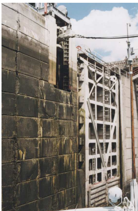
Les plus grandes portes à vantaux atteignent 15 à 20 m. - sur le canal Volga-Baltique (écluse 6) Rus. - sur le Dniepr, à Kremenchouk (Ukr).
