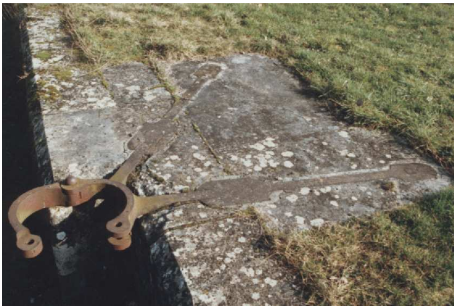
Tirant de porte à l'écluse de moulin brulé. Canal de Briare (F 45).
