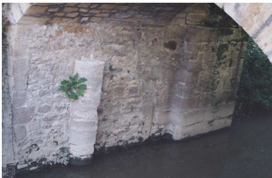
Emplacement des portes. Pont-écluse de Thouarcé Canal du Layon (F 49).
