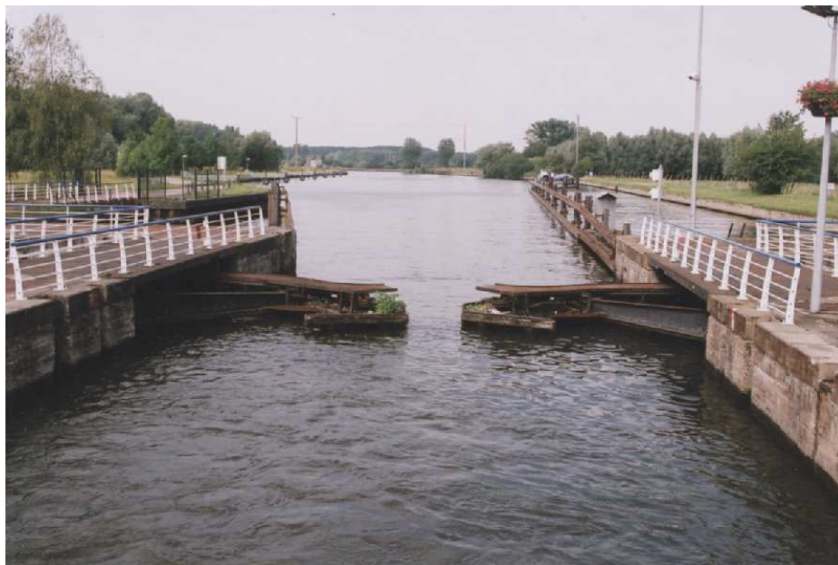
Ecluse du Don, sur la Deule (F 59). Porte à vantaux cintrés.
