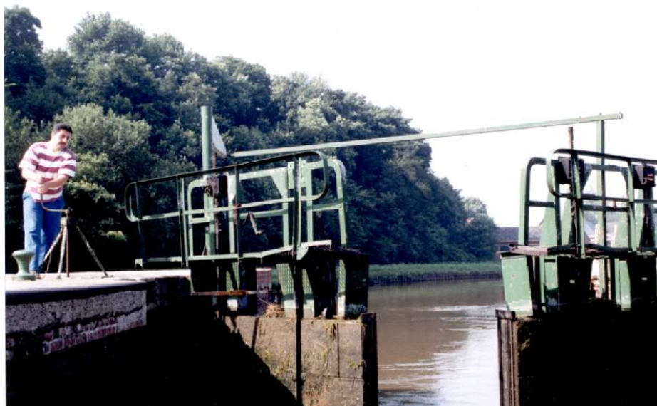
Ouverture simultanée des deux vantaux de la porte aval. Ecluse de l'échelle d'Etreux. Canal de la Sambre à l'Oise (F 02).
