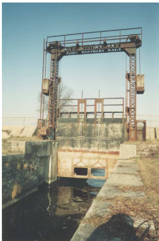
L'archaïque écluse à guillotine de Saint Just (F 10) et ses contrepoids. Canal de la haute Seine.
