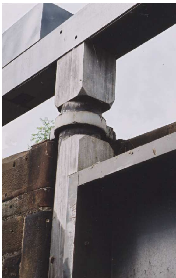
Poteau tourillon d'une porte du Forth and Clyde canal (GB)
