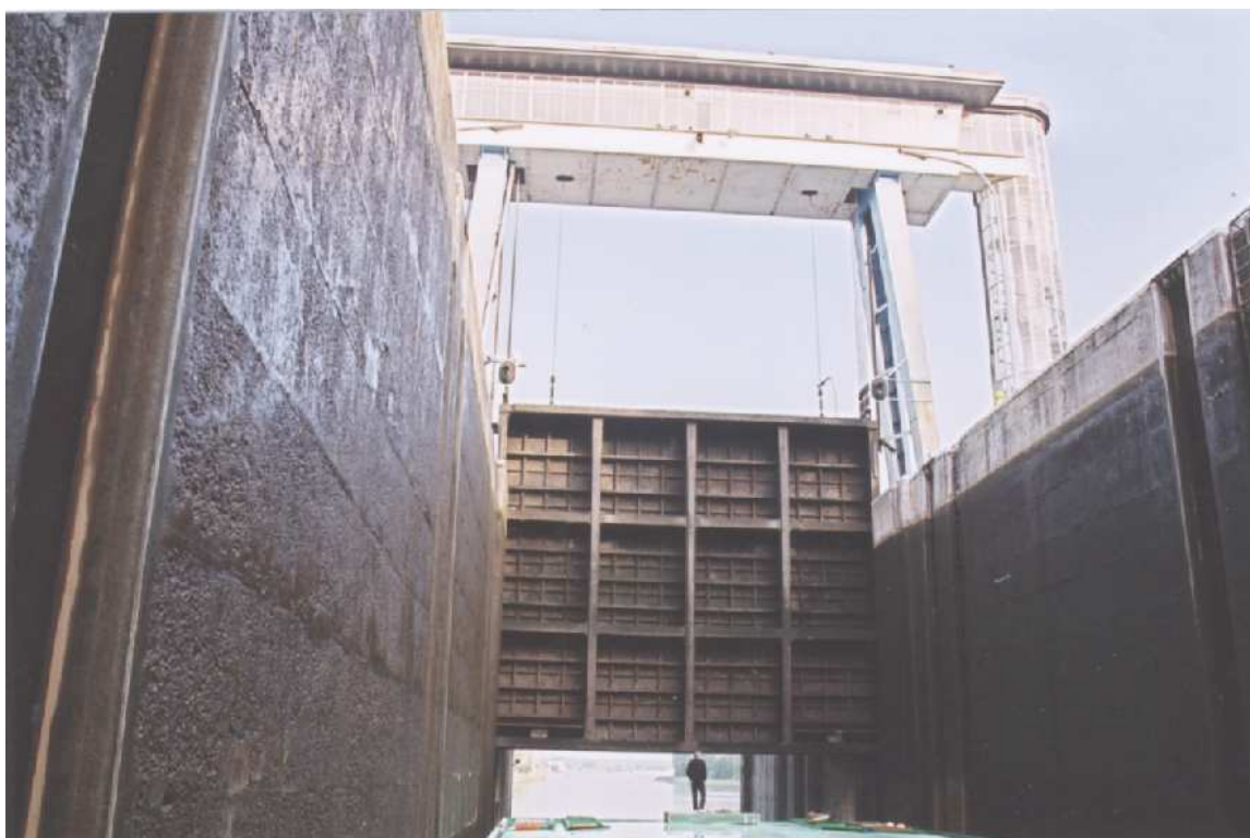
L'archaïque écluse à guillotine de Saint Just (F 10) et ses contrepoids. Canal de la haute Seine.
