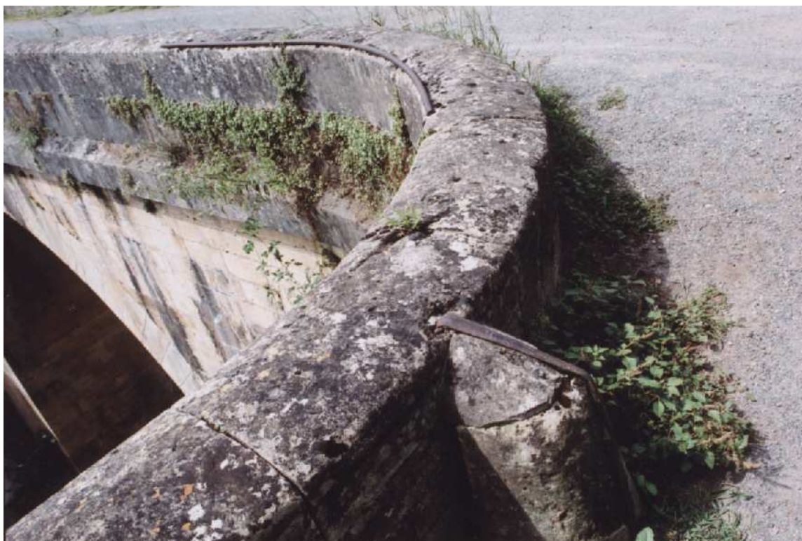
Les tiges métalliques, scellées sur les parapets, évitent l'usure des cordages sur l'arête des pierres. (Echelle de Lalinde F 24)
