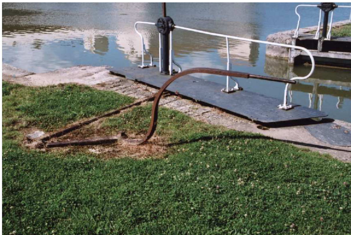
Ouverture de porte à Pouilly (F 21) Canal de Bourgogne.
