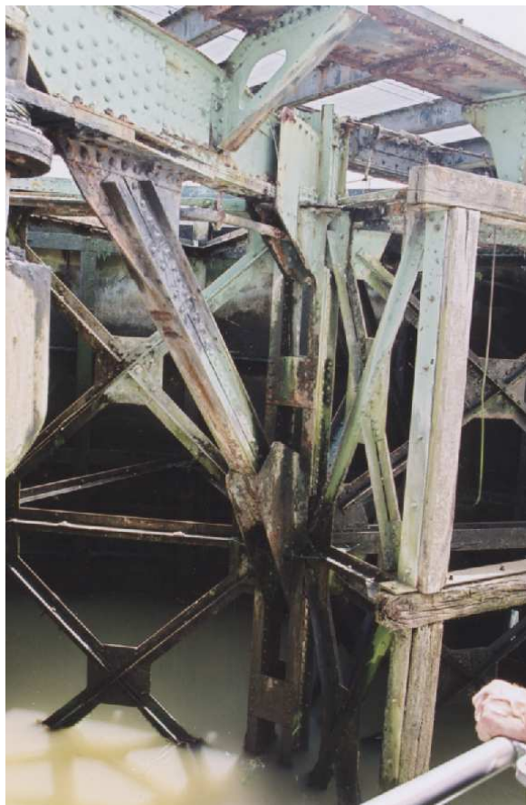
Ecluse de Flandre, à Arques (F 62). Axe d'une porte à vantaux cintrés.
