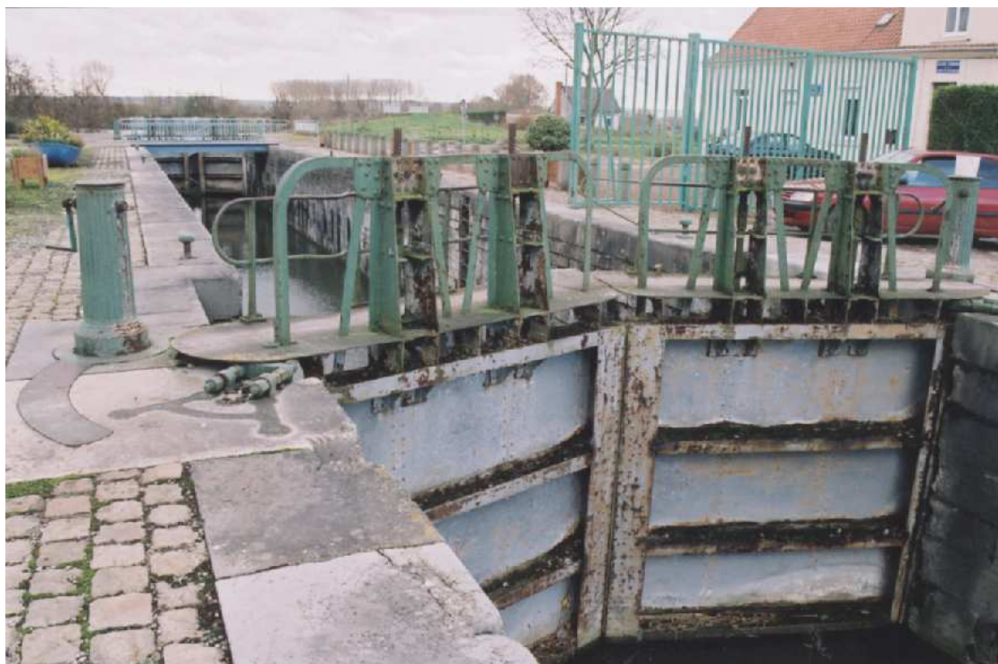
Ancienne écluse d'Henuin. Canal de Calais (F 62). Borne à manivelle.
