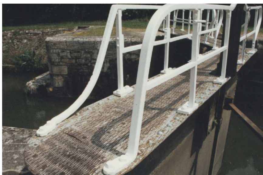
Passerelle sur les portes de l'écluse de Brisebarre. Canal du Loing (F 45).
