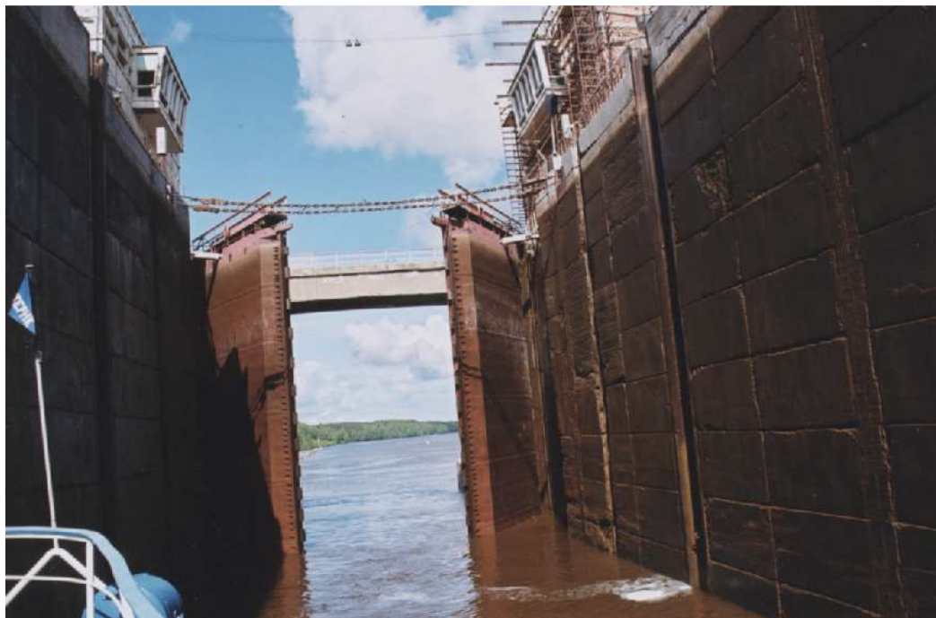
Les plus grandes portes à vantaux atteignent 15 à 20 m. - sur le canal Volga-Baltique (écluse 6) Rus. - sur le Dniepr, à Kremenchouk (Ukr).
