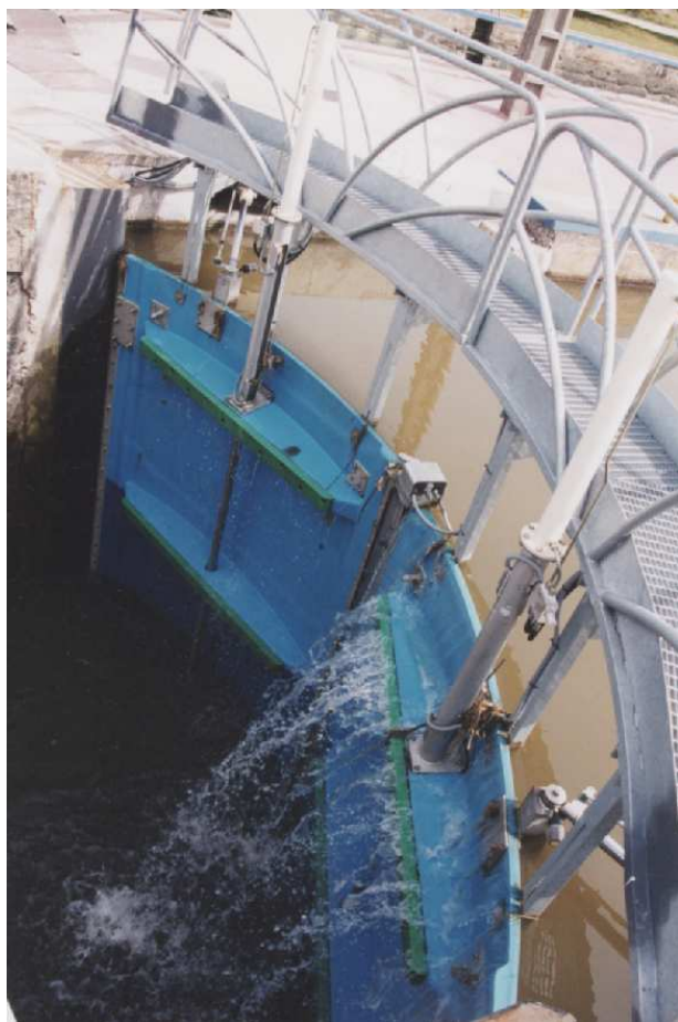
Porte en Polyester. Echelle de Golbey. Canal des Vosges (F 88).
