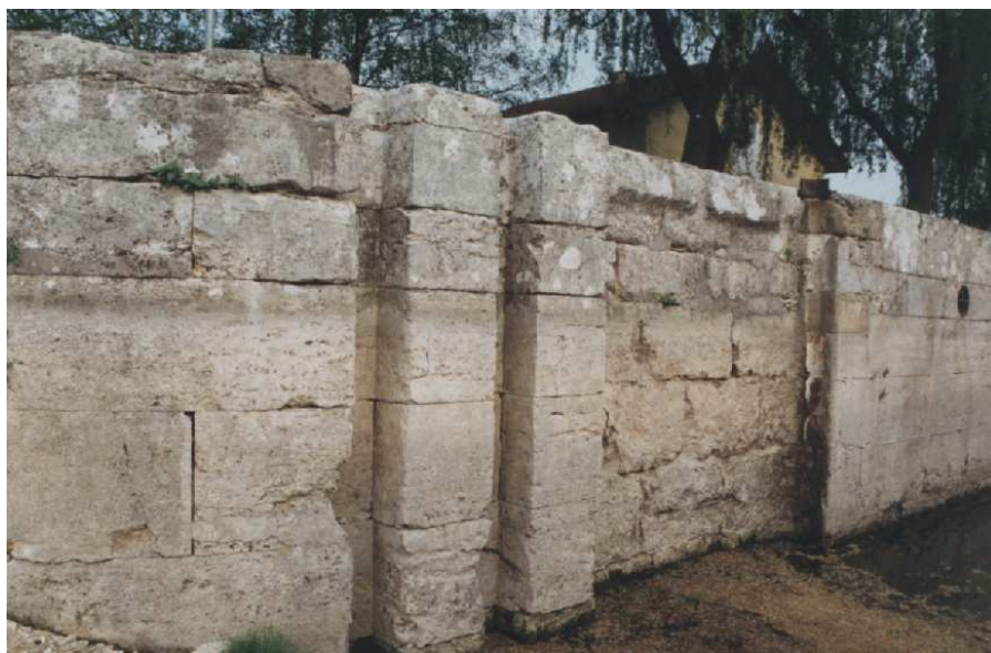
Coulisses, chambres des portes, chardonnet de l'écluse de Deising –Ludwig Kanal –(D).
