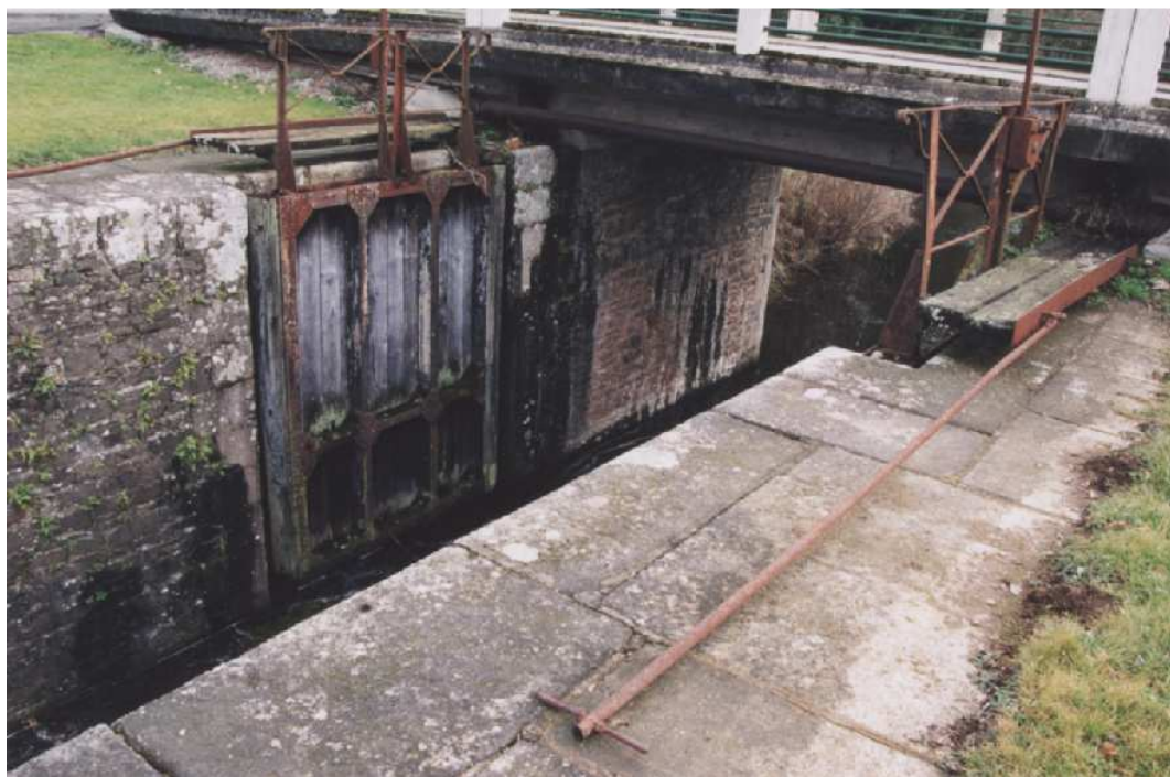
La porte se manœuvre à la perche. Ecluse de Quénécan, sur le Canal de Nantes à Brest abandonné (F 22).
