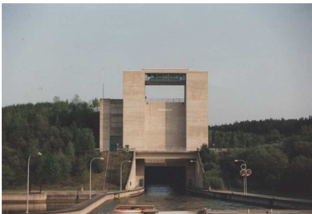
Montée de la porte aval de l'écluse de Leerstetten, sur le RM DK (D).
