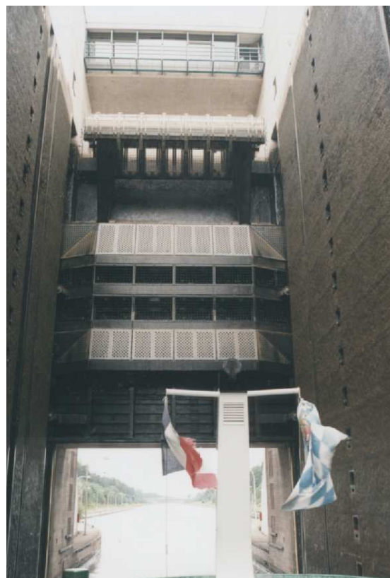
Montée de la porte aval de l'écluse de Leerstetten, sur le RM DK (D).
