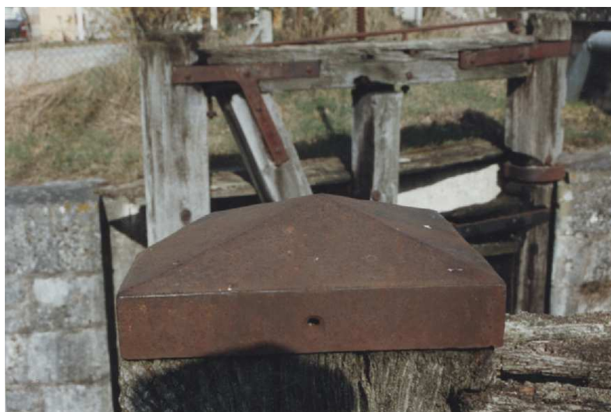
Capuchon de fer protégeant l'extrémité des poteaux. Ecluse du milieu de Grignon. Canal d'Orléans (F 45).
