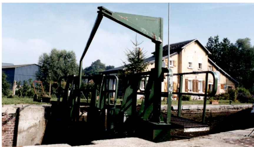
Ouverture simultanée des deux vantaux de la porte aval. Ecluse de l'échelle d'Etreux. Canal de la Sambre à l'Oise (F 02).
