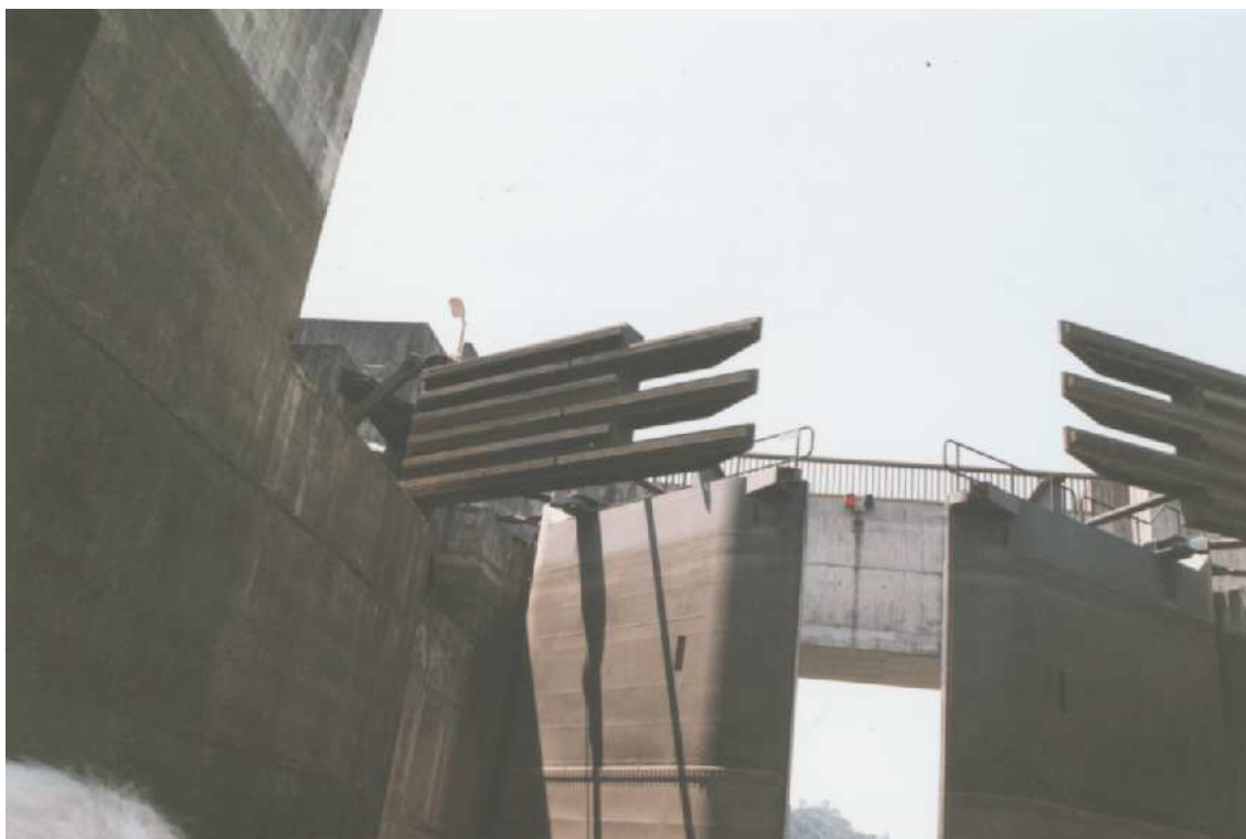
Défenses entrecroisées de l'écluse de Crestuma, sur le Douro (P).
