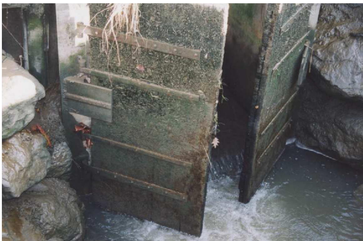
Porte de marée à Dèze, sur l'Adour (F 64).
