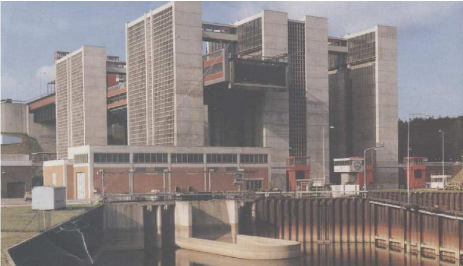
Les Belges – qui possèdent les différentes techniques de « monte-bateau » : hydraulique à la Louvière, plan incliné à Ronquières – réalisent aussi le plus haut ascenseur funiculaire, à Strepv-Thieu, pour remplacer les quatre ascenseurs de la Louvière, entre la Meuse et l'Escaut.
