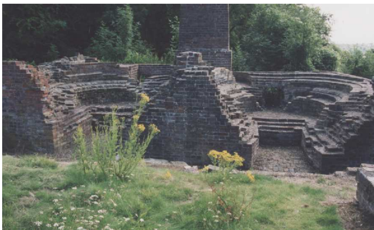
Plan incliné de Hay (GB) substructions de la machine à vapeur.
