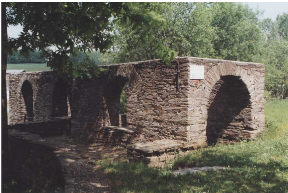
Freiberg – 3 Sortie haute de l'ascenseur
