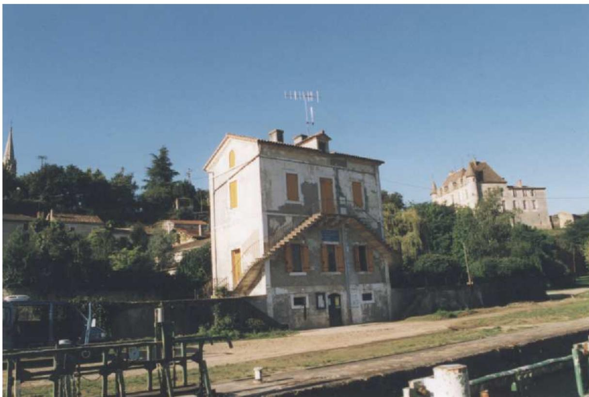
*Escalier de crue à l'écluse de Castets en Dorthe (F-33) extrémité du canal de la Garonne.*
