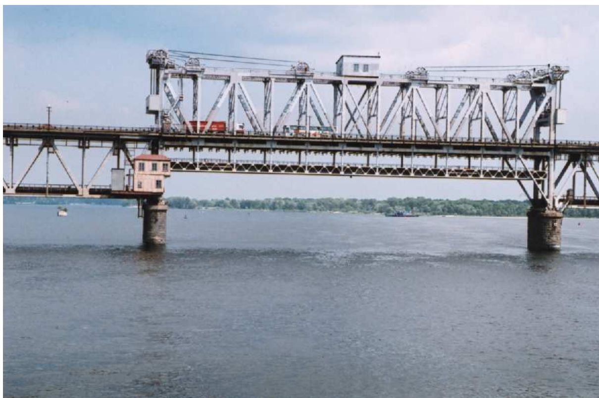
Pont-levant route et fer (1876) de Krementchouck (Ukr)
