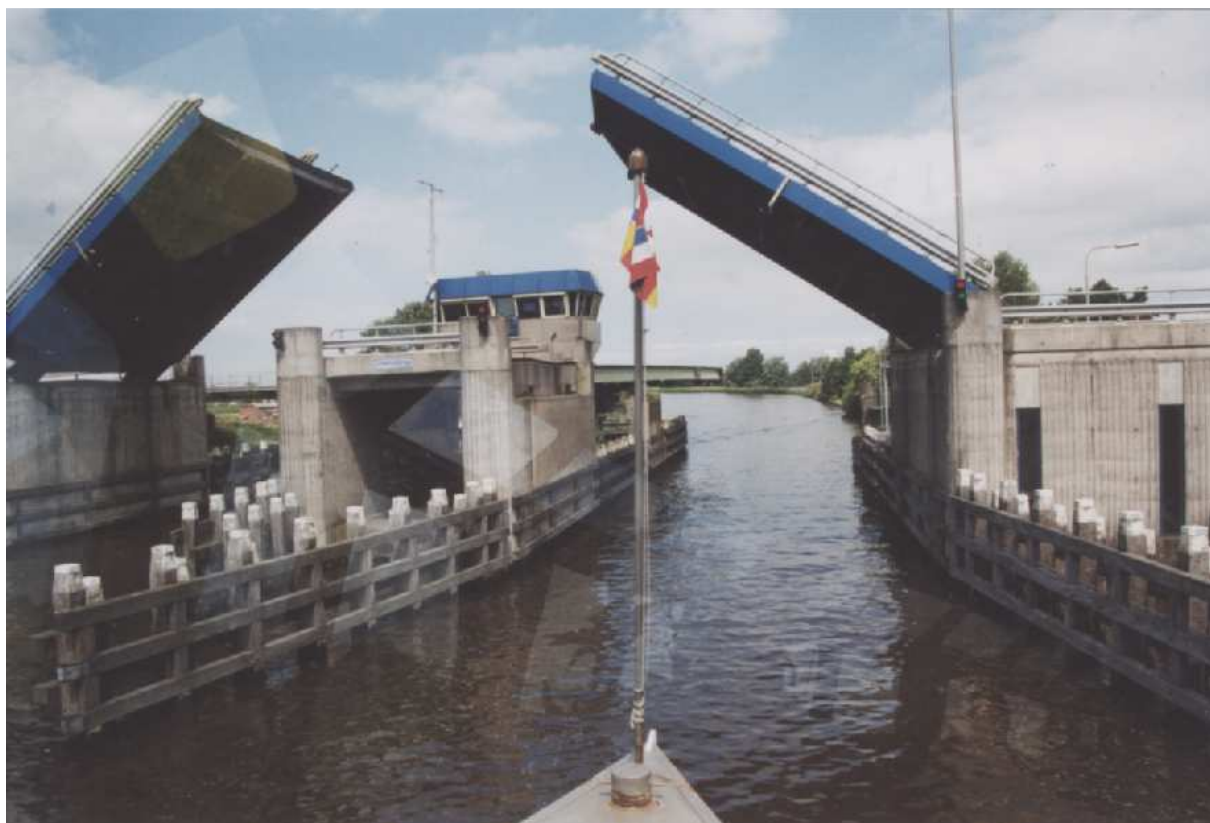
Double pont-bascule de l'écluse Franecker. Canal Harinxma (NL)
