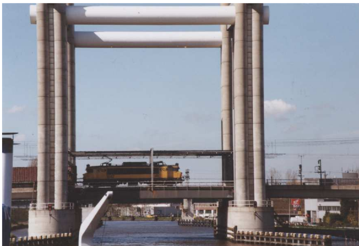
Pont-levant route et fer de Gouda, sur le canal de Gouwe (NL)
