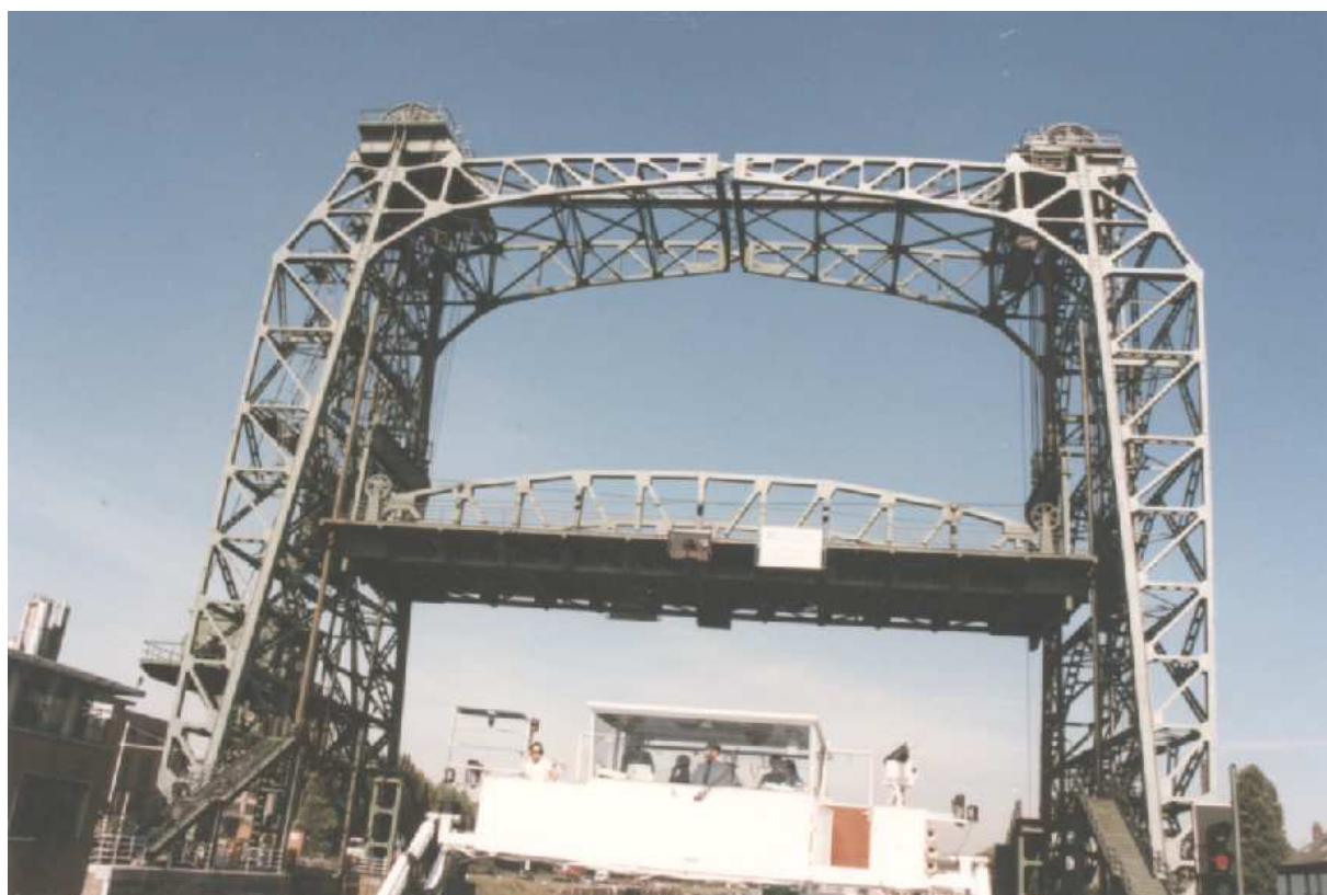
Pont-levant de Vilvorde, sur le canal Bruxelles-Rupel (B)
