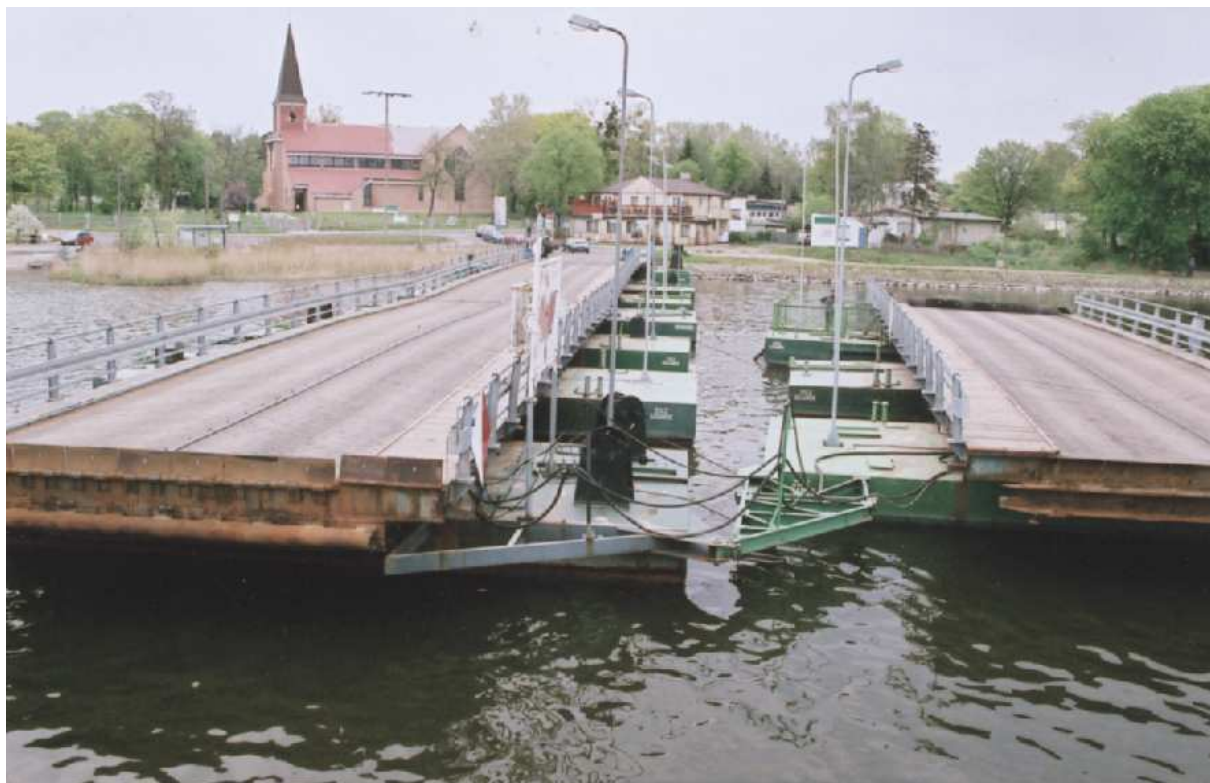
Ouverture d'un pont de bateaux, à Gdansk (Pol)
