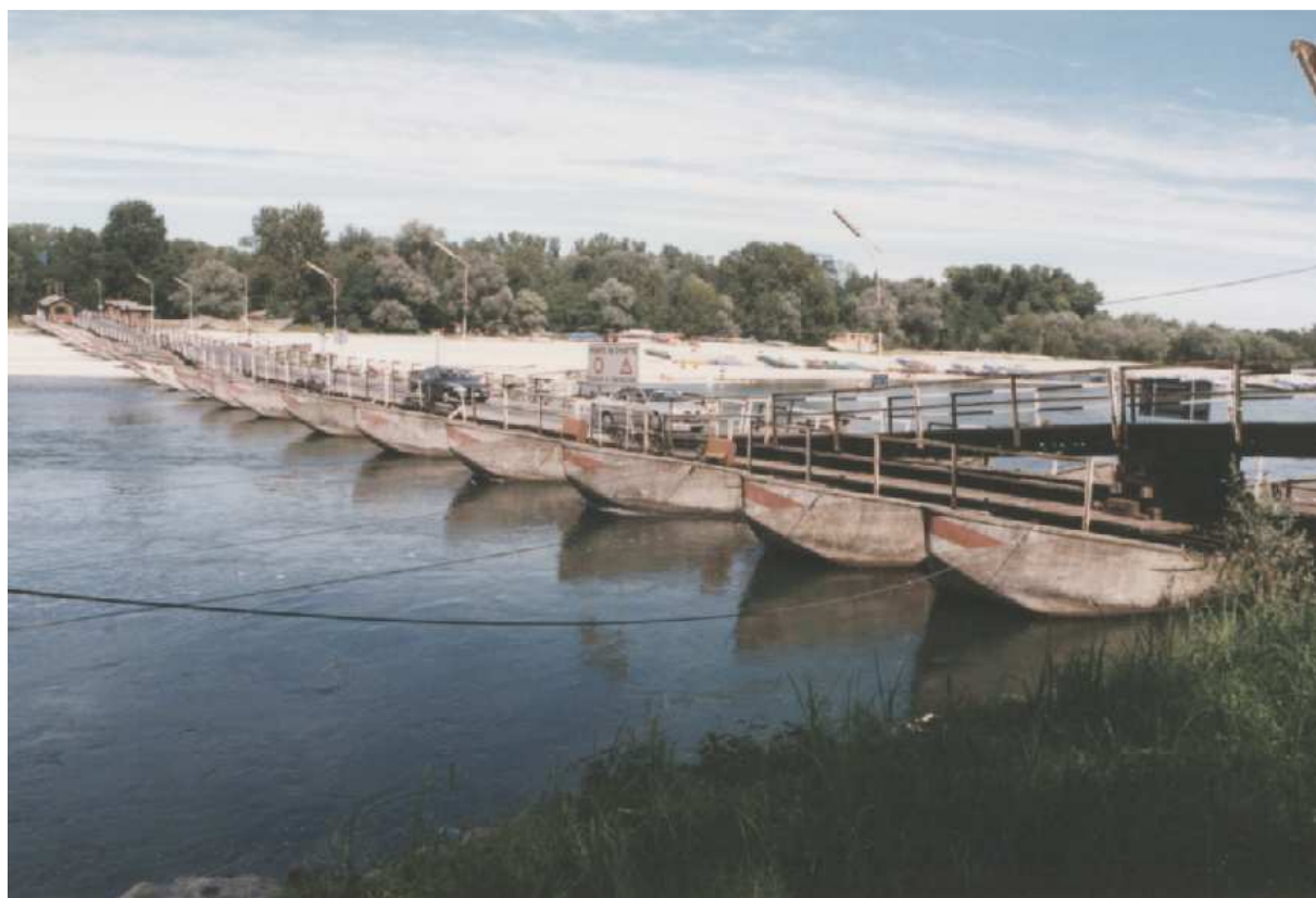
Pont de bateaux de Bereguardo, sur le Tessin (I)
