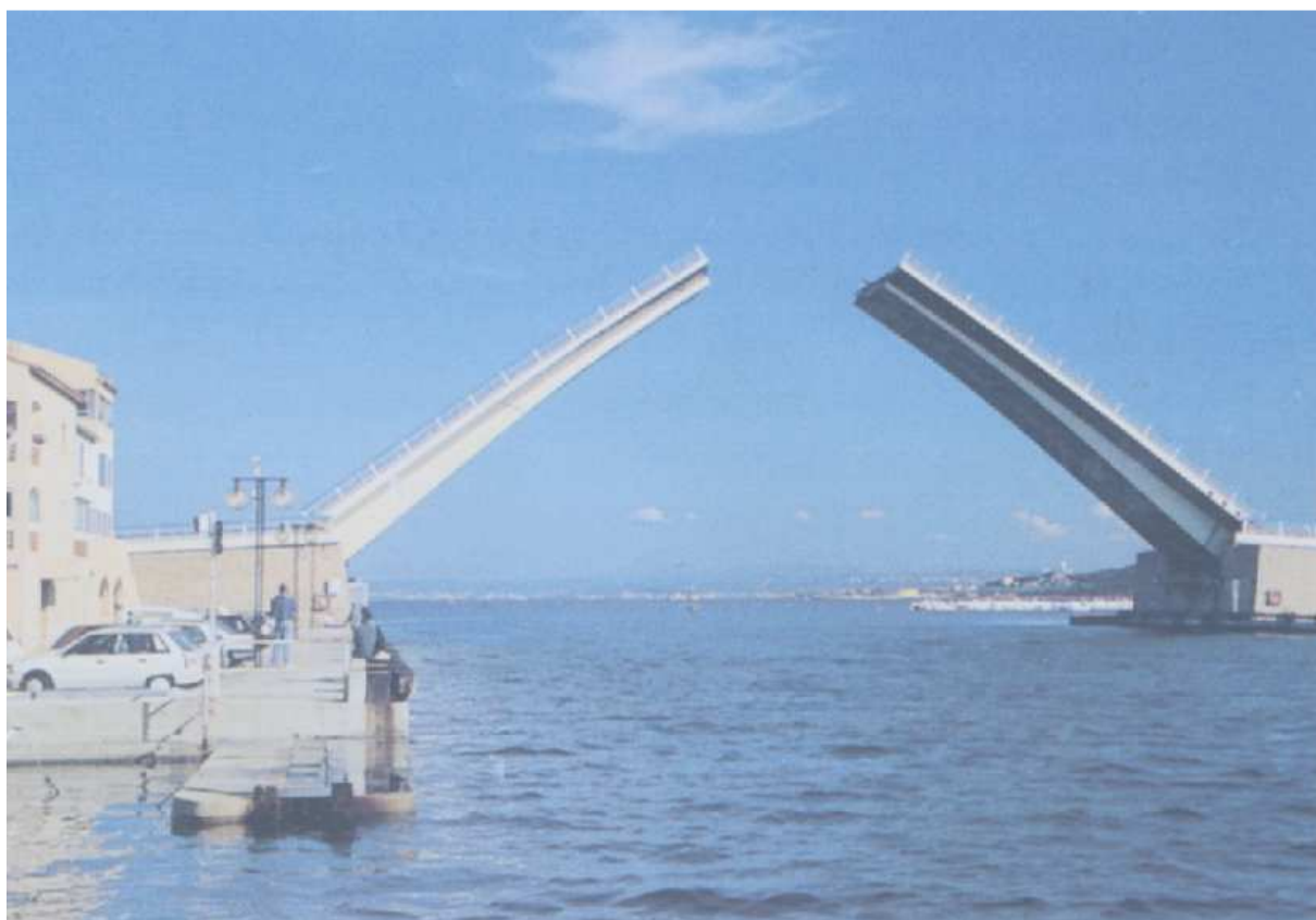
Double pont-bascule ouvrant sur l'étang de Berre – Martigues (F-13)
