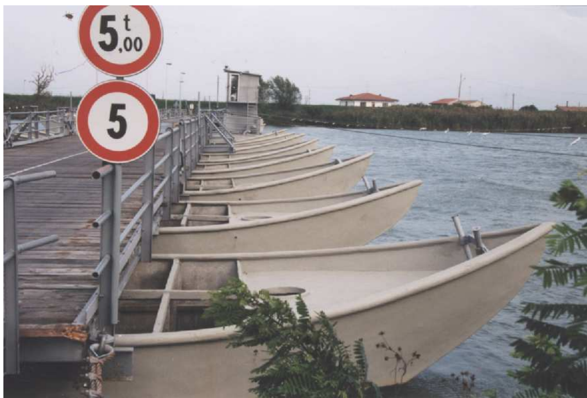
Pont de bateaux sur le Pô di Goro, à Gorino Veneto (I)
