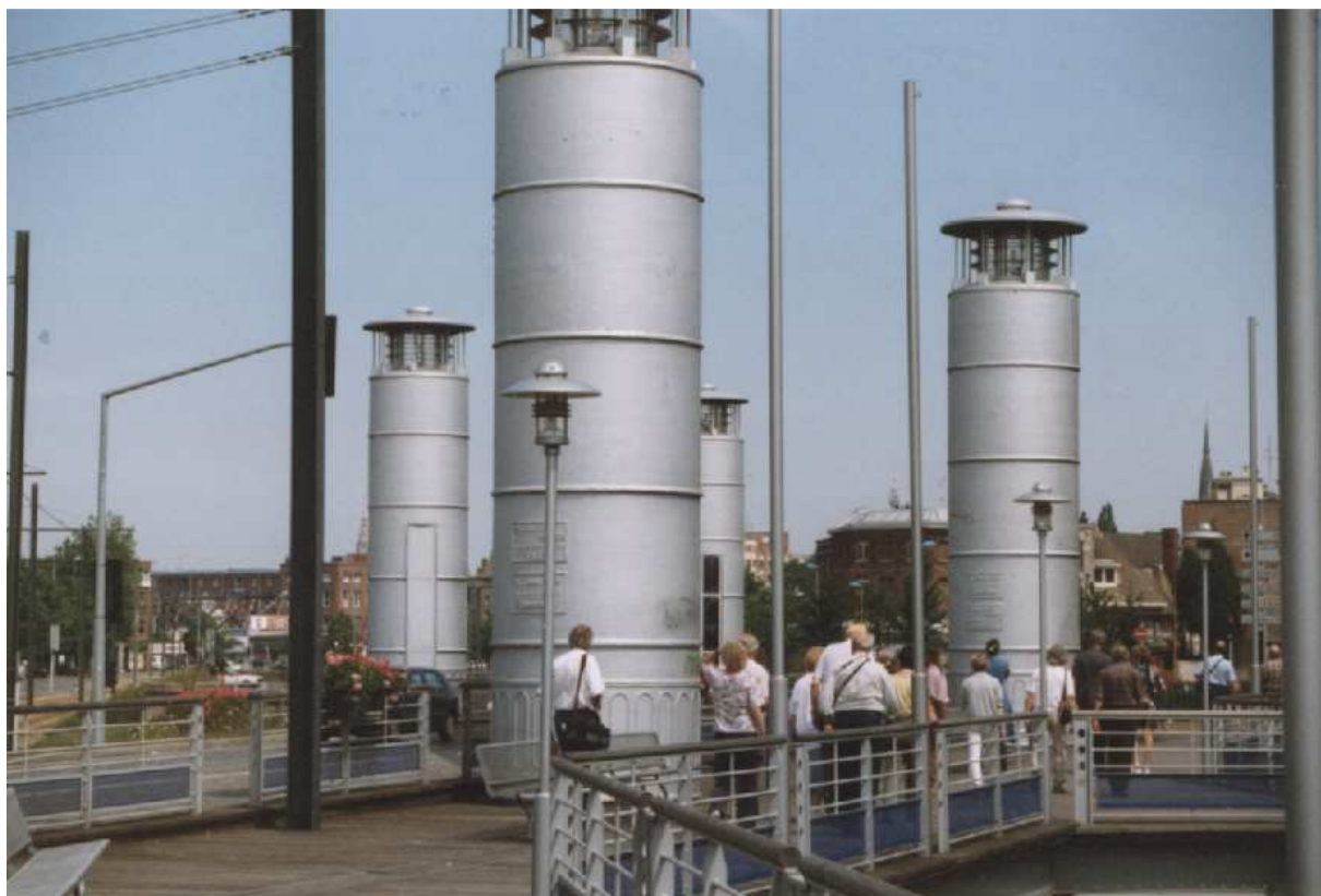
Pont-levant (sans moteurs) du boulevard Lille-Tourcoing, sur le canal de Roubaix (F-59)
