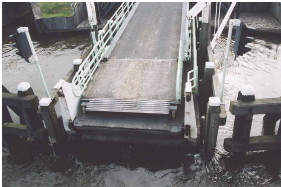
Un des ponts flottants du canal Nord Holland
