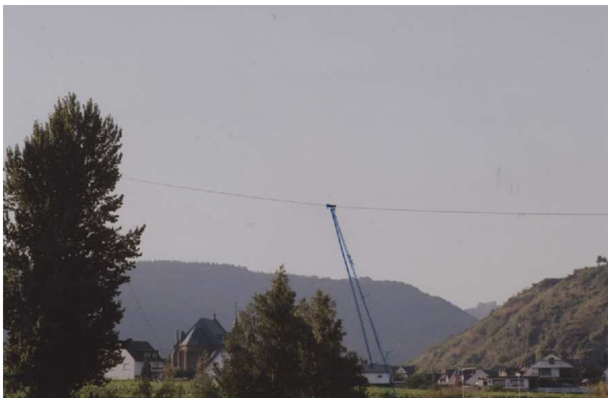
Le trolley sur son câble tient les amarres avant-arrière du passeur à traile perpendiculaire de Belstein, sur la Moselle (D)
