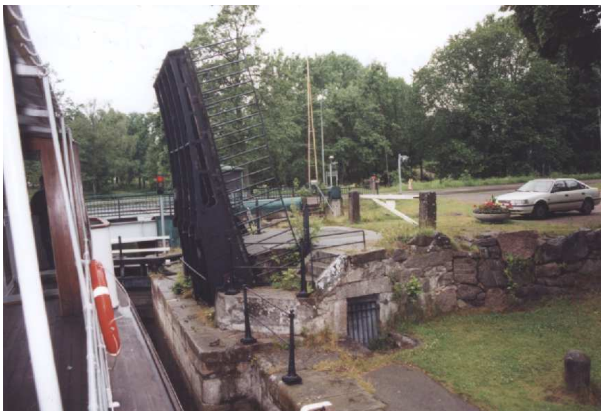
Le local demi enterré où loge le contrepoids est bien visible
