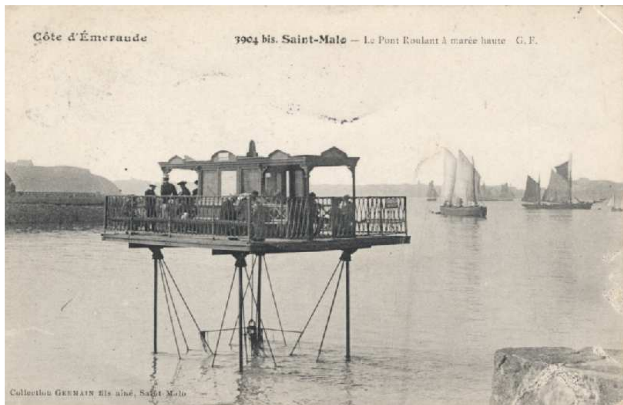
La nacelle roulant en baie de Saint-Malo -1900
