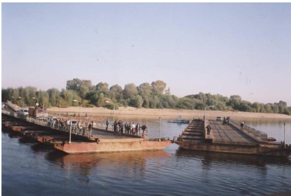
A Pavlov, sur l'Oka (Rus) le pousseur referme la partie mobile du pont de bateaux.
