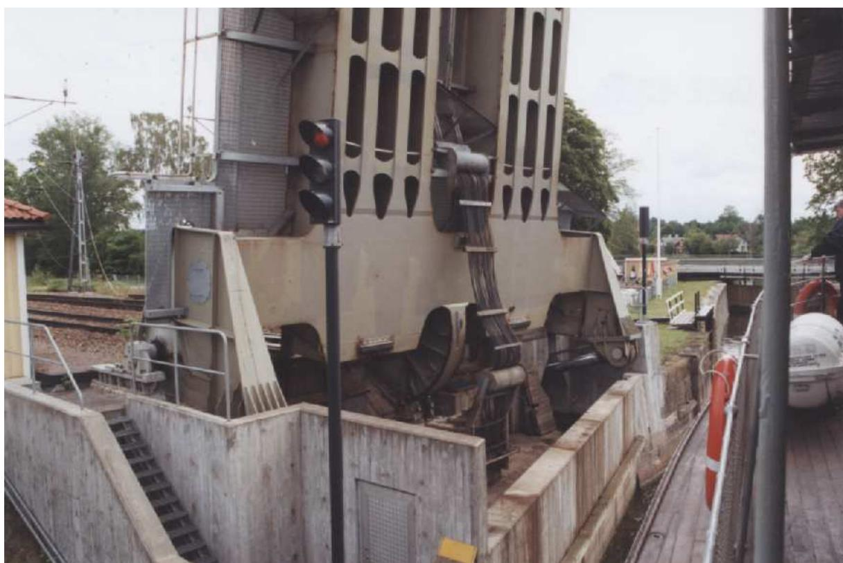
*Mécanisme du pont-bascule ferroviaire de l'écluse de Norsholm Gota canal (S)*
