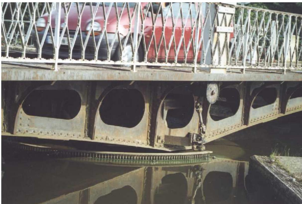
*Mécanisme du pont tournant à manivelle de Jorquenay (F-52) Canal de la Marne à la Saône*
