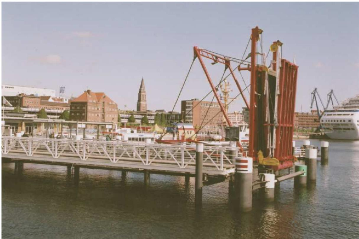
*Le pont-levis multiple, au fond du port de Kiel (D) est le plus étonnant des ponts-levis : le tablier se divise en trois parties. Au repos, elles sont stockées verticalement. En marche, elles se déplient jusqu'à la rive en face, soutenues par un jeu de portiques et de câbles*
