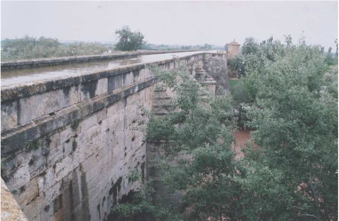
Canal impérial d'Aragon (E) Pont-canal de Grisen, à Alagon sur le rio Jalon, par Pignatelli, XVIII e s.
