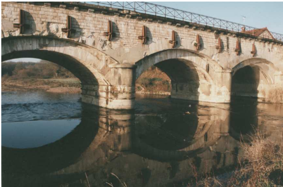
Canal de Berry, sur le Cher (F-18) Pont canal de la Tranchasse – 1832. Après son élargissement – 1872 – des tirants maintiennent la cohésion de l'ensemble.
