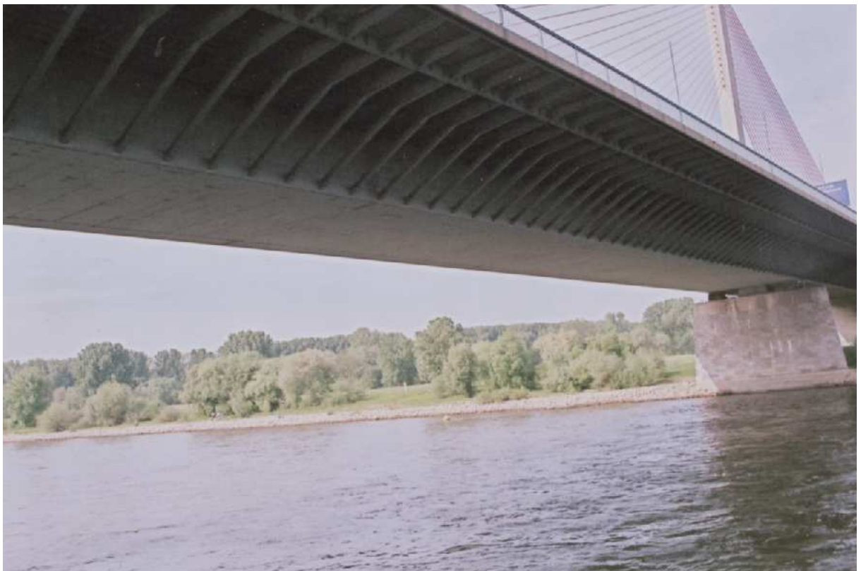
Bonn (D) haubans en éventail soutenant une dalle de béton
