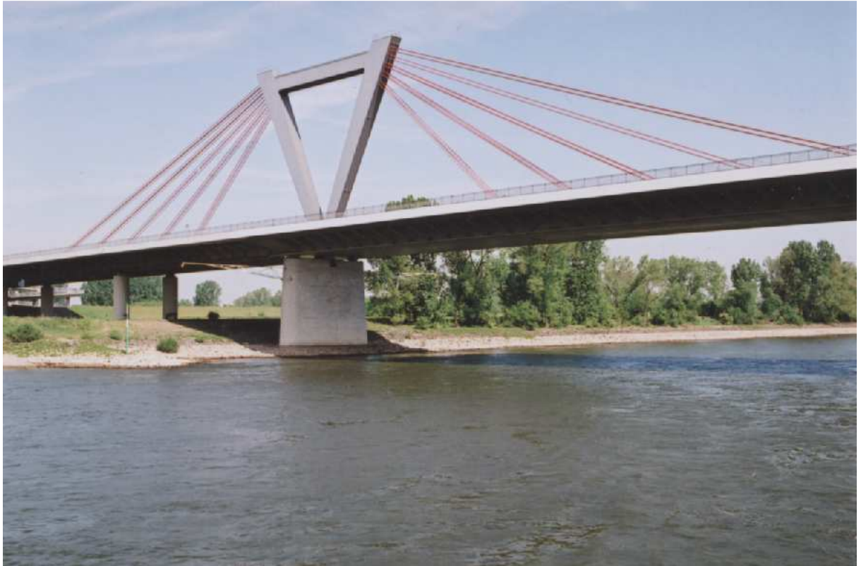
Pylône en « A » renversé : Düsseldorf (D)
