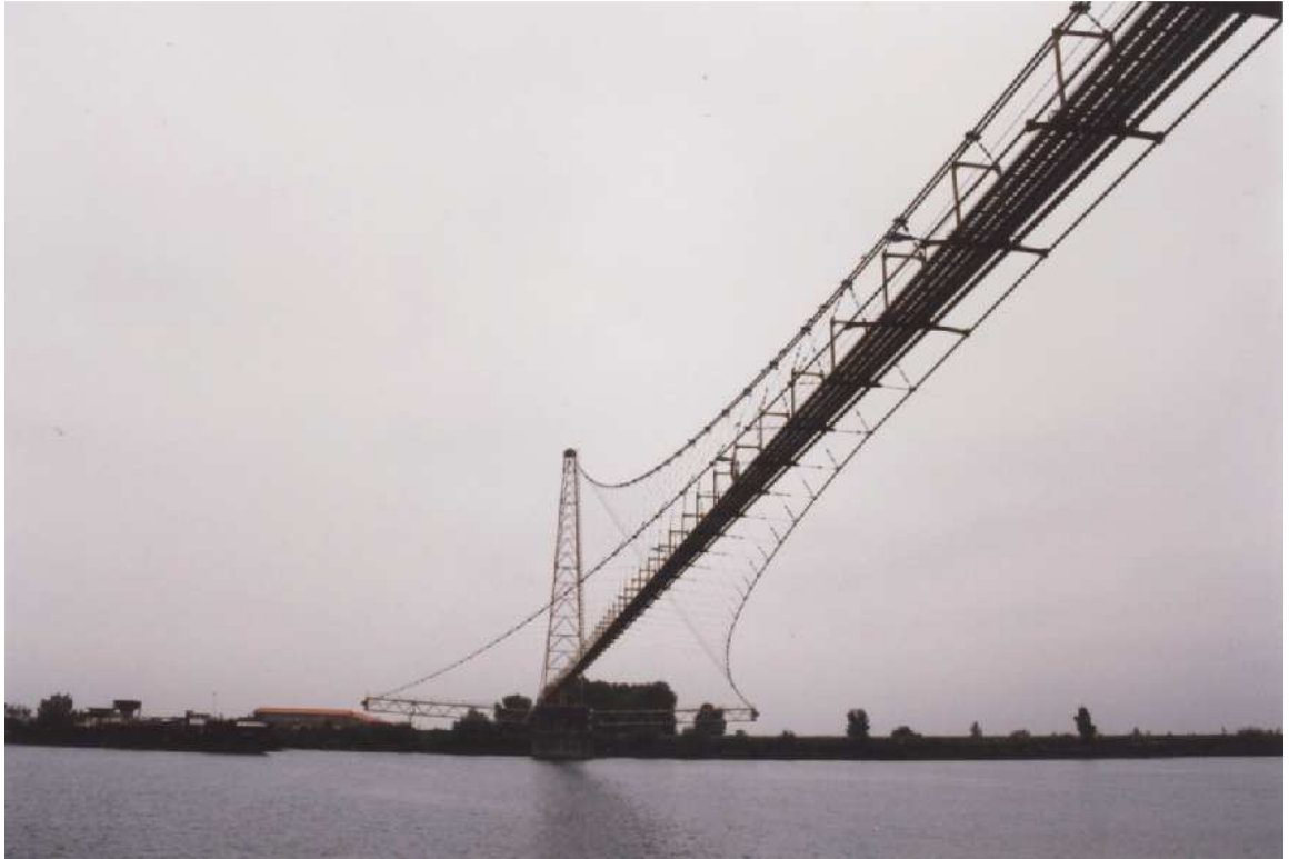
Les ponts suspendus portent aussi des tuyaux. Feeder de Smederevo, sur le Danube (Serbie)
