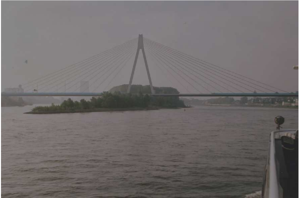
Pont de Weissenthurm (D) La poutre – caissons en acier – soutient des bracons
