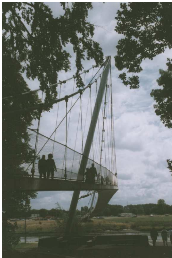
Passerelle de la « Weser promenade » à Minden (D)
