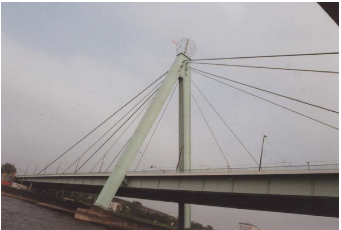
Pont Severins à Koln (D) Premier grand pylône en « A ». Haubans en éventail – 1959
