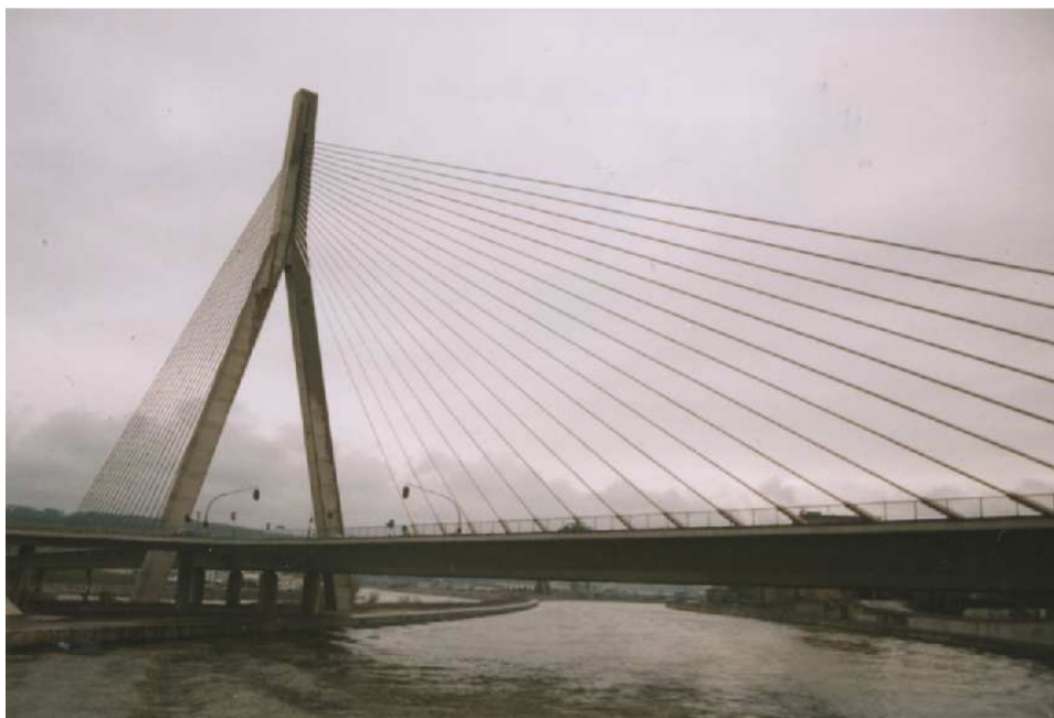
Pont sur le canal Albert (B) Harpe d'un côté, éventail de l'autre
