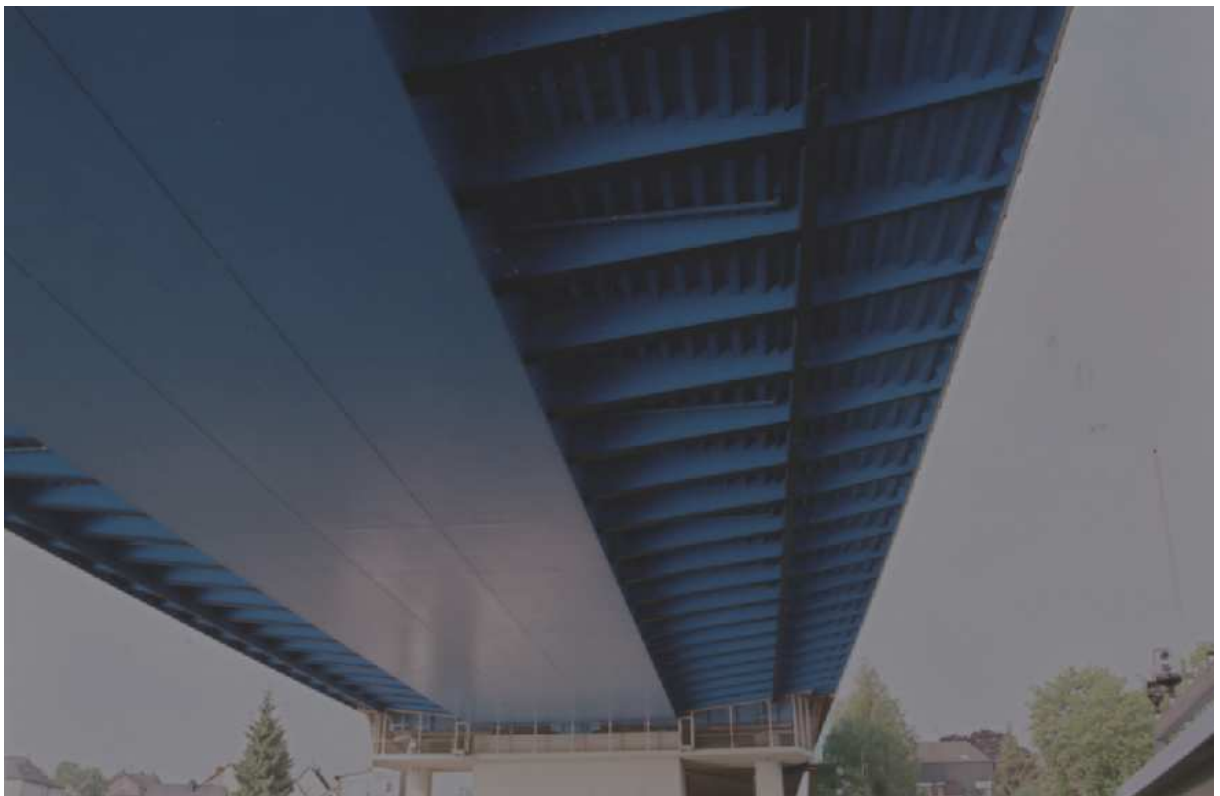
Pont de Weissenthurm (D) La poutre – caissons en acier – soutient des bracons
