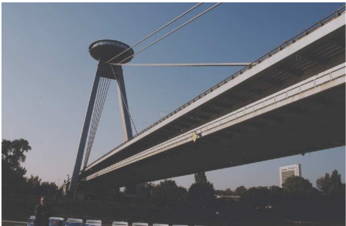
Le Danube à Bratislava (SK) Pont de 400m sur un seul pylône (80m) portant un café – 1972
