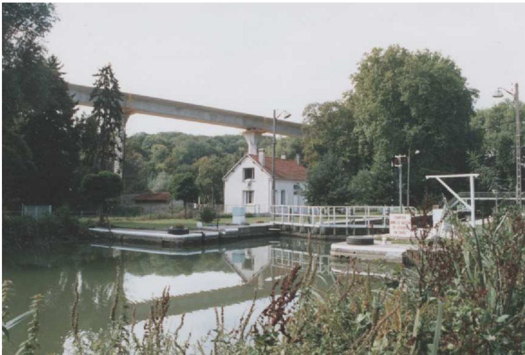
Le pont courbe du TGV d'interconnexion de Paris domine l'écluse de Lesches (F-77) sur le canal de Chalifert.
