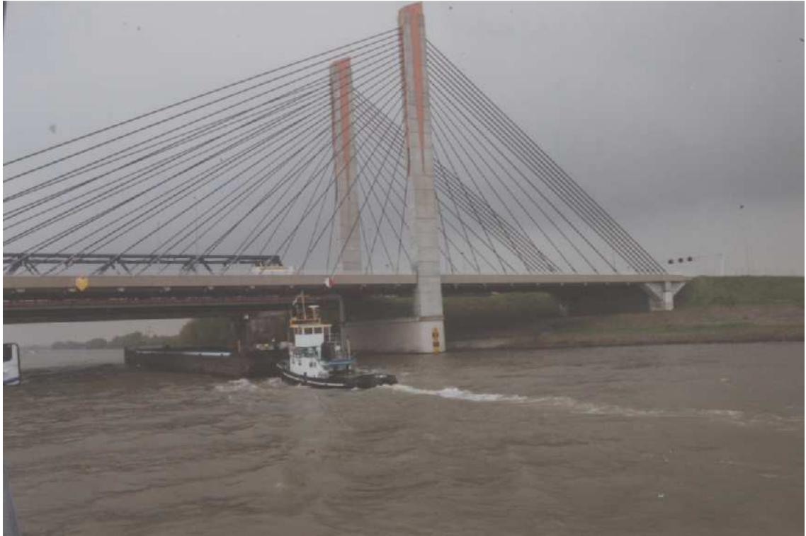
Pont sur le Waal (NL) 2 pylônes – voies doubles fer et route
