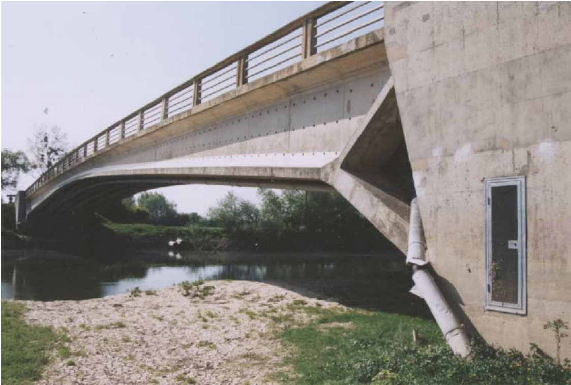
Trilbardou (F-77) l'un des cinq ponts « précontraints » construits sur la Marne par Freyssinet. Noter la triangulation sur la pile.
