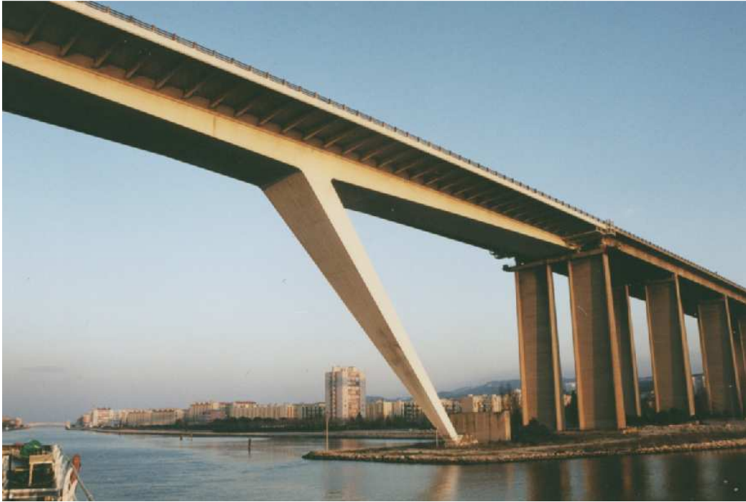
Pont à béquilles (1971) de l'autoroute A55 sur le canal de Caronte (F-13)
