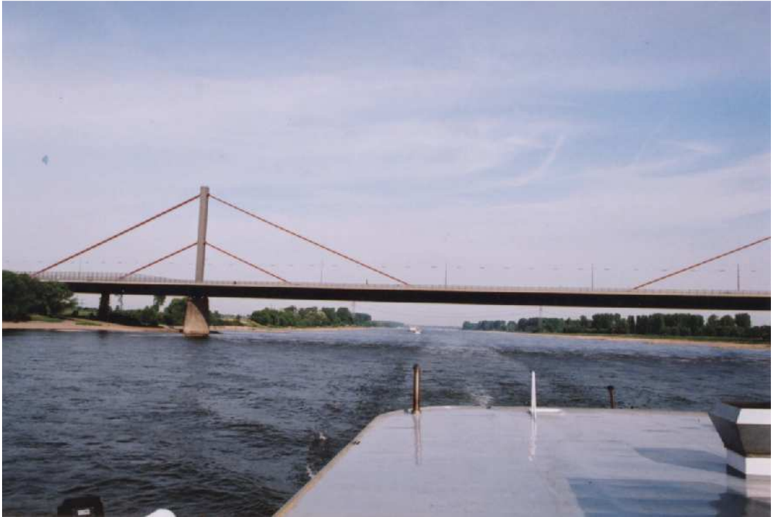
Pont de Rheindorf (D) Deux pylônes – câbles en harpe
