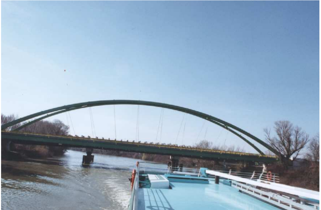
Pont de Saint Gilles (F-30) sur le petit Rhône
