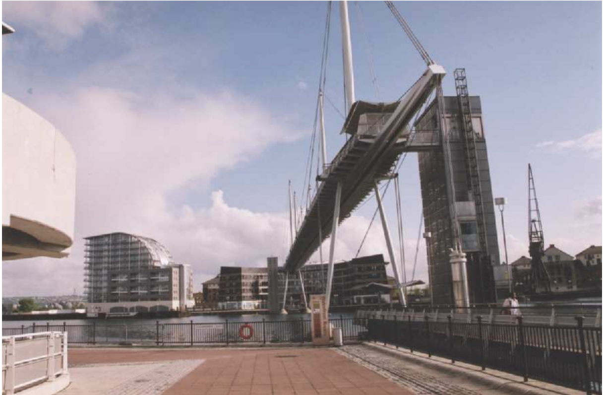
Une passerelle desservie par ascenseurs. Victoria docks, à Londres
