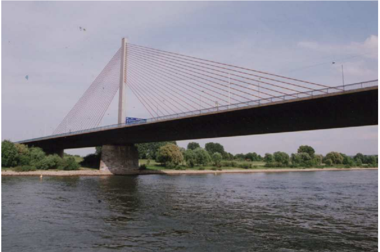
Bonn (D) haubans en éventail soutenant une dalle de béton
