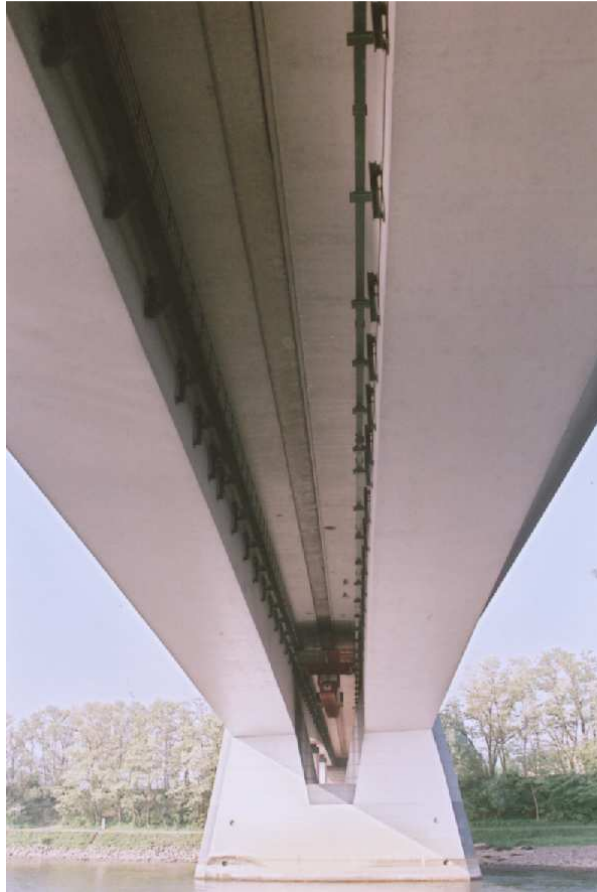
Au pont-route de Koblenz-Nord, il y a deux poutres en béton. La voie est entre les deux (D)
