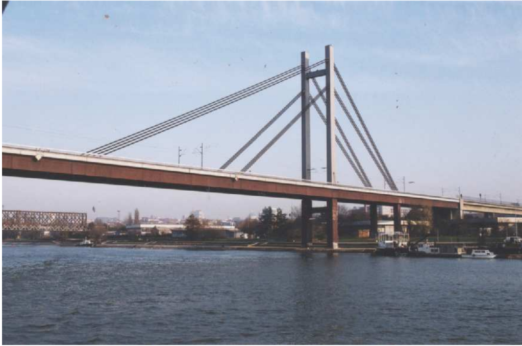
Pont sur la Sava, à Belgrade (SR 1956). Poutre-caissons en acier. Pendant la guerre de Yougoslavie, la foule se portait sur les ponts pour dissuader les américains de les bombarder
