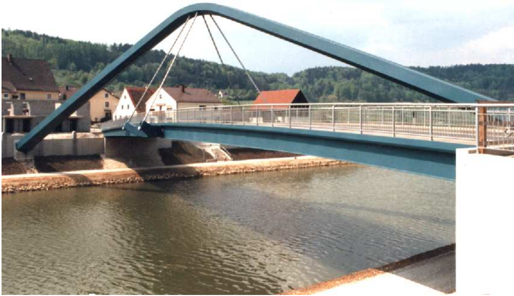
Pont de Plankstetten – Main – Donau Kanal (D)
