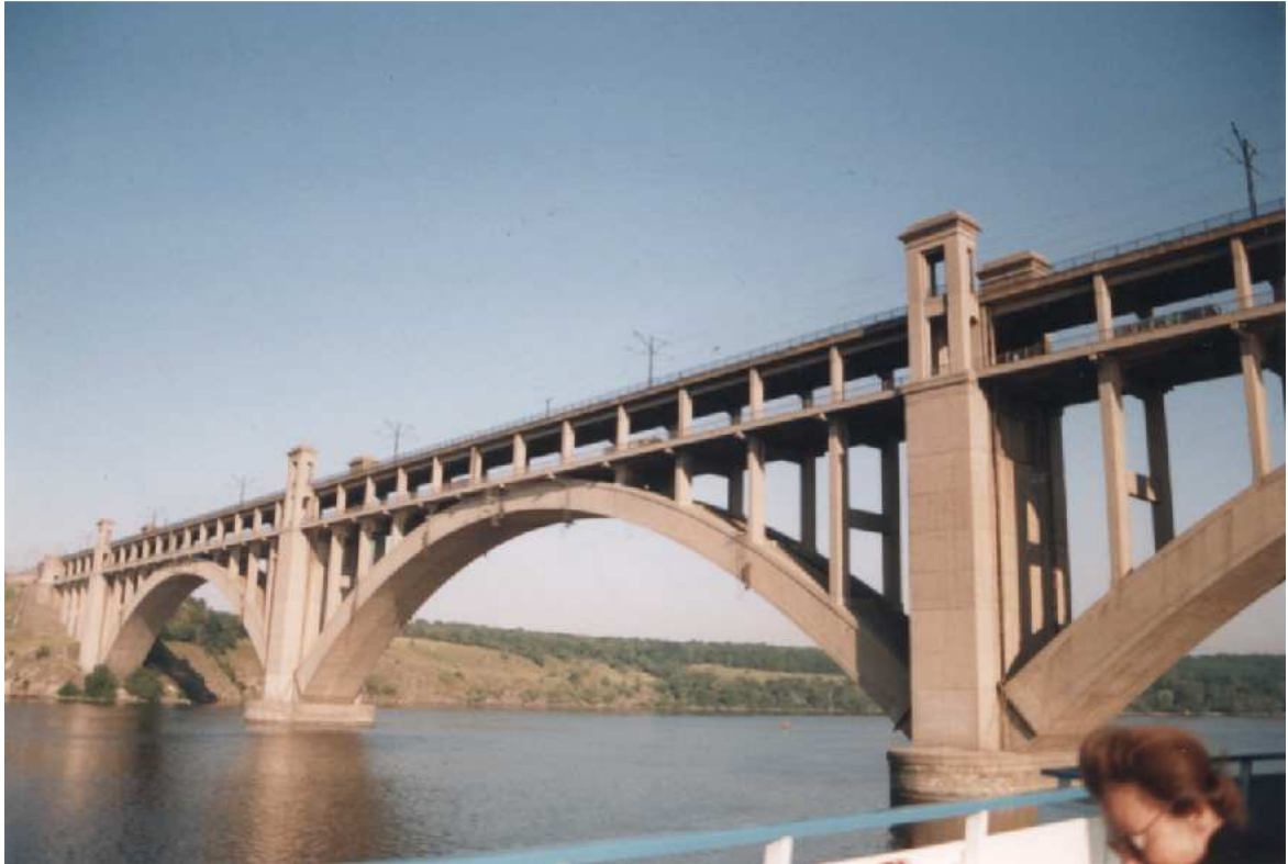
Pont fer et route de Zaporoje (Ukr)
