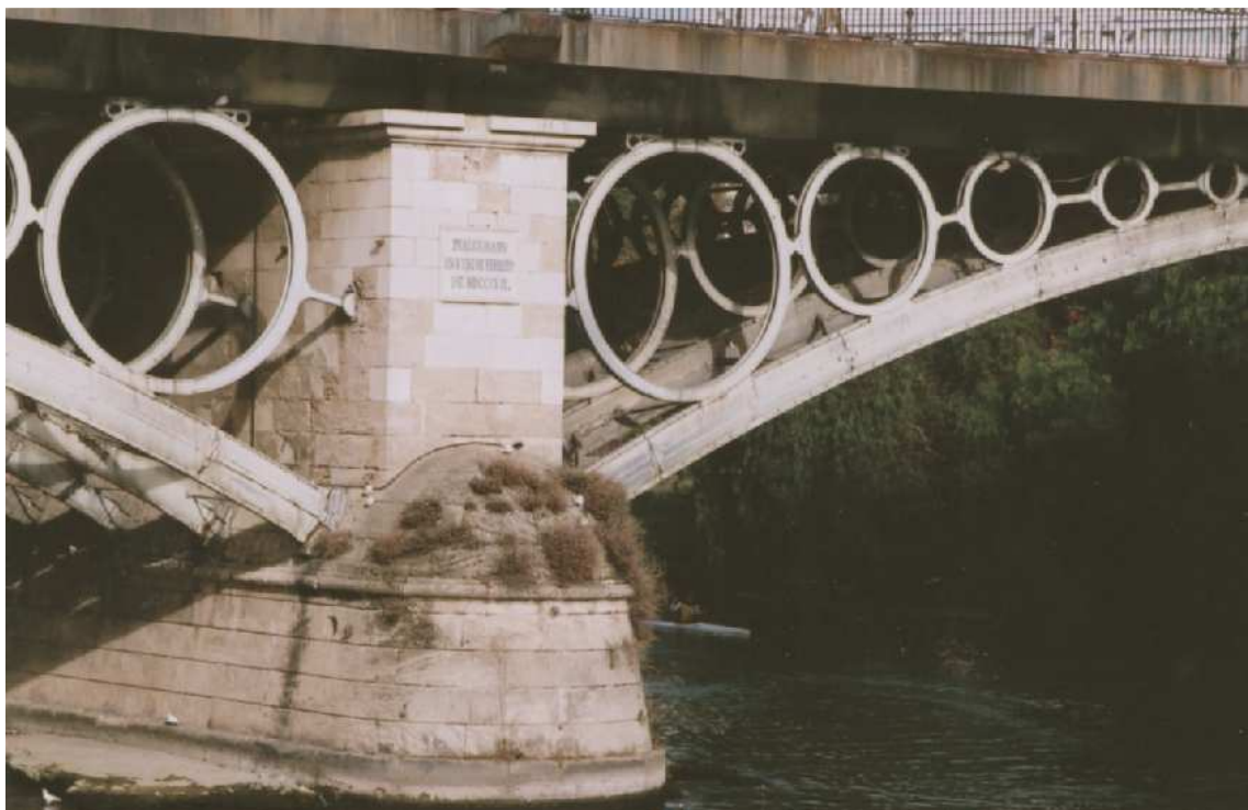
Séville (E) Pont Isabelle II (ou de Triana) sur le Guadalquivir Copie du pont parisien du Carrousel en fonte, de Polonceau (1834)
