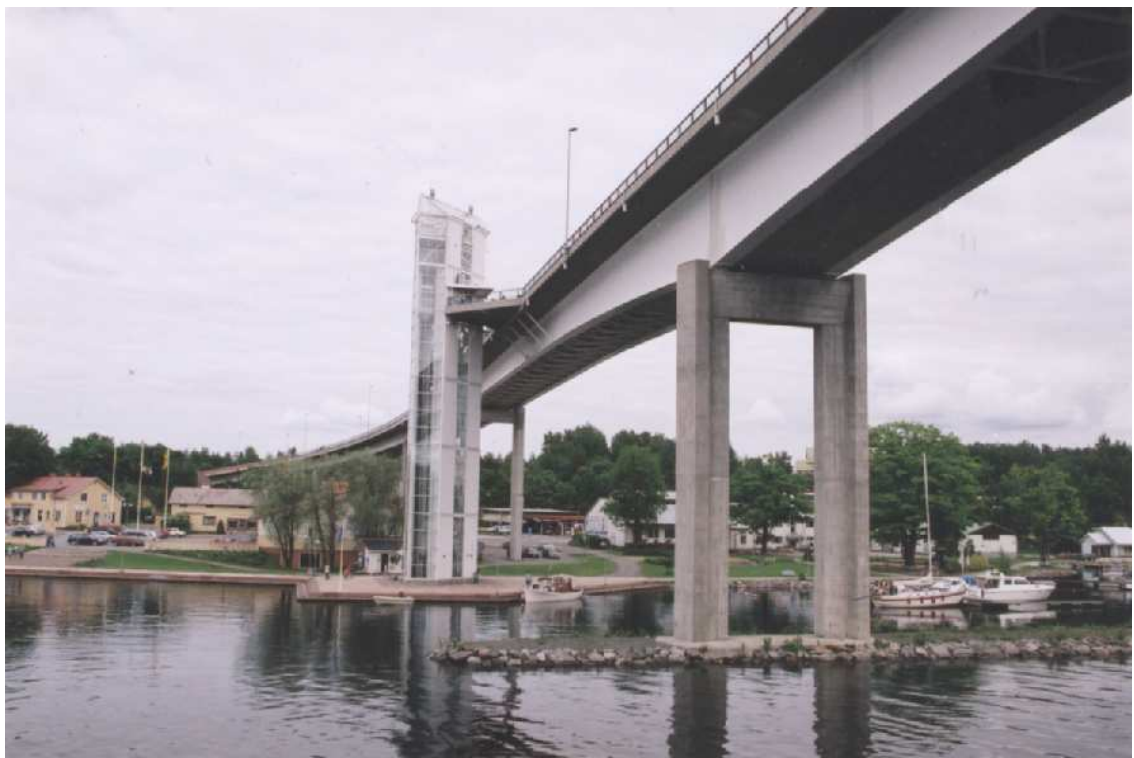
Pont routier flanqué d'un ascenseur, à Puumala, sur le lac de Saimaa (Fin)
