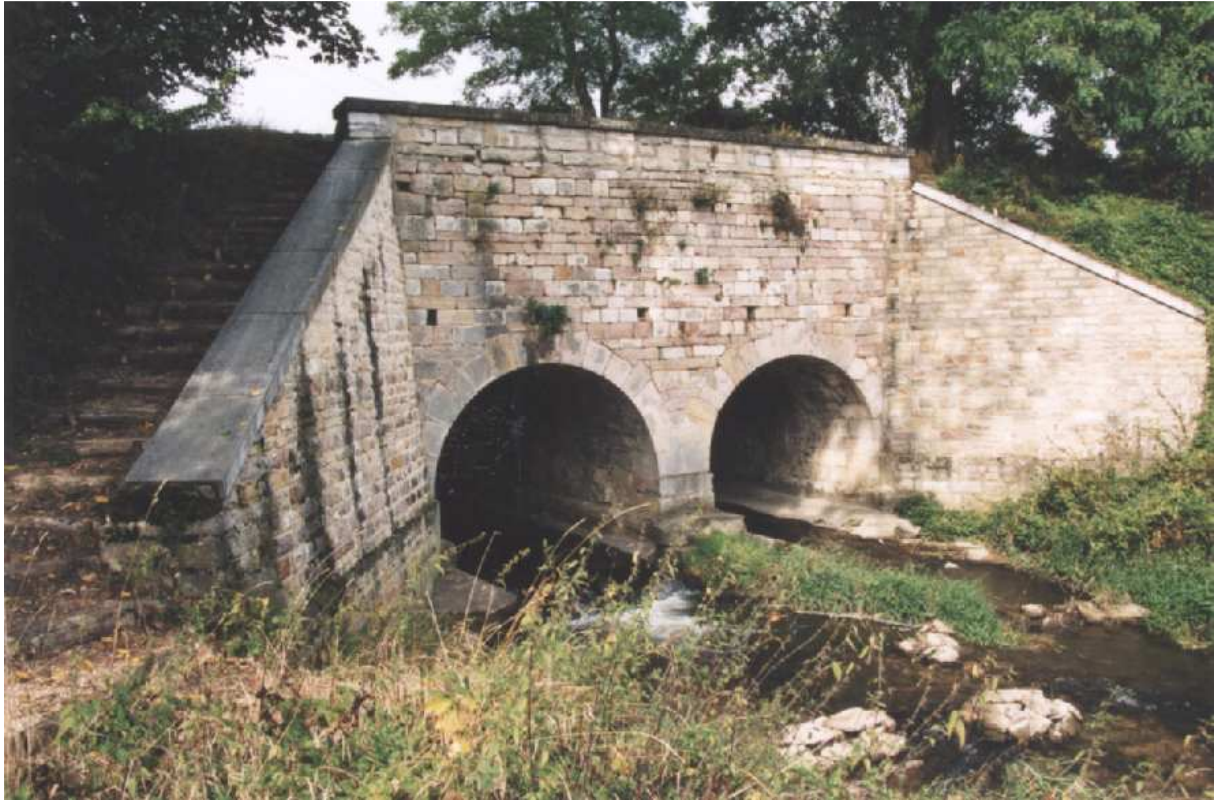
Pont-canal des Arvaux, à Noiron sous Gevrey (F-21) XIII e s. et 1746
