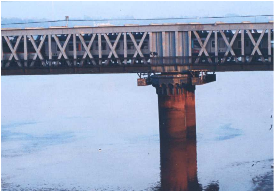
Pile du pont-fer de Bordeaux (F-33)
