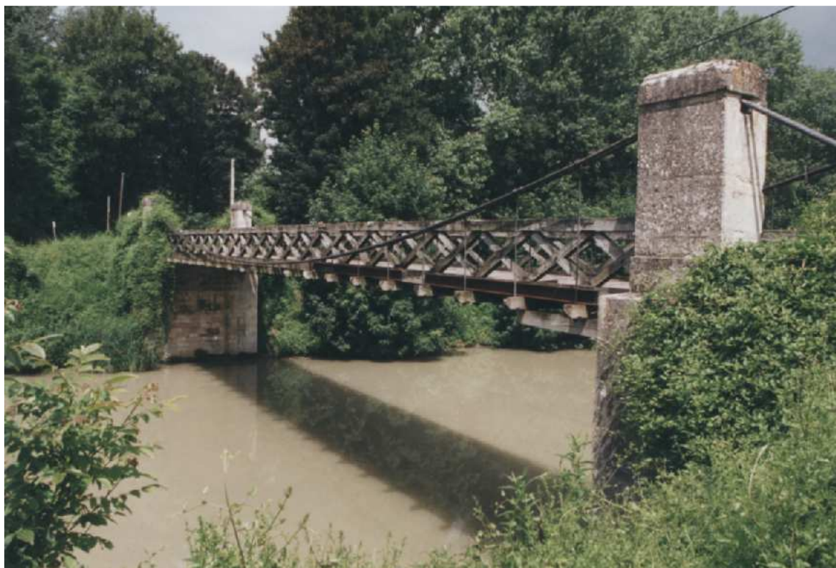
Pont des roizes à Mareuil-les-Meaux (F-77) Canal de Chalifert
