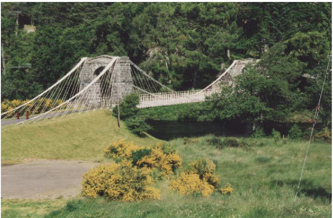
Elégance d'un petit pont suspendu, à Oich, sur le Caledonian canal (Ecosse)
