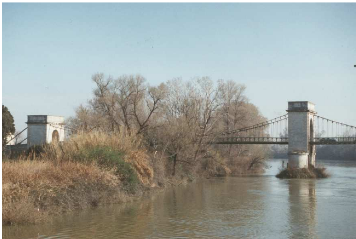
Pont suspendu à Fourques, sur le petit Rhône (F-30)
