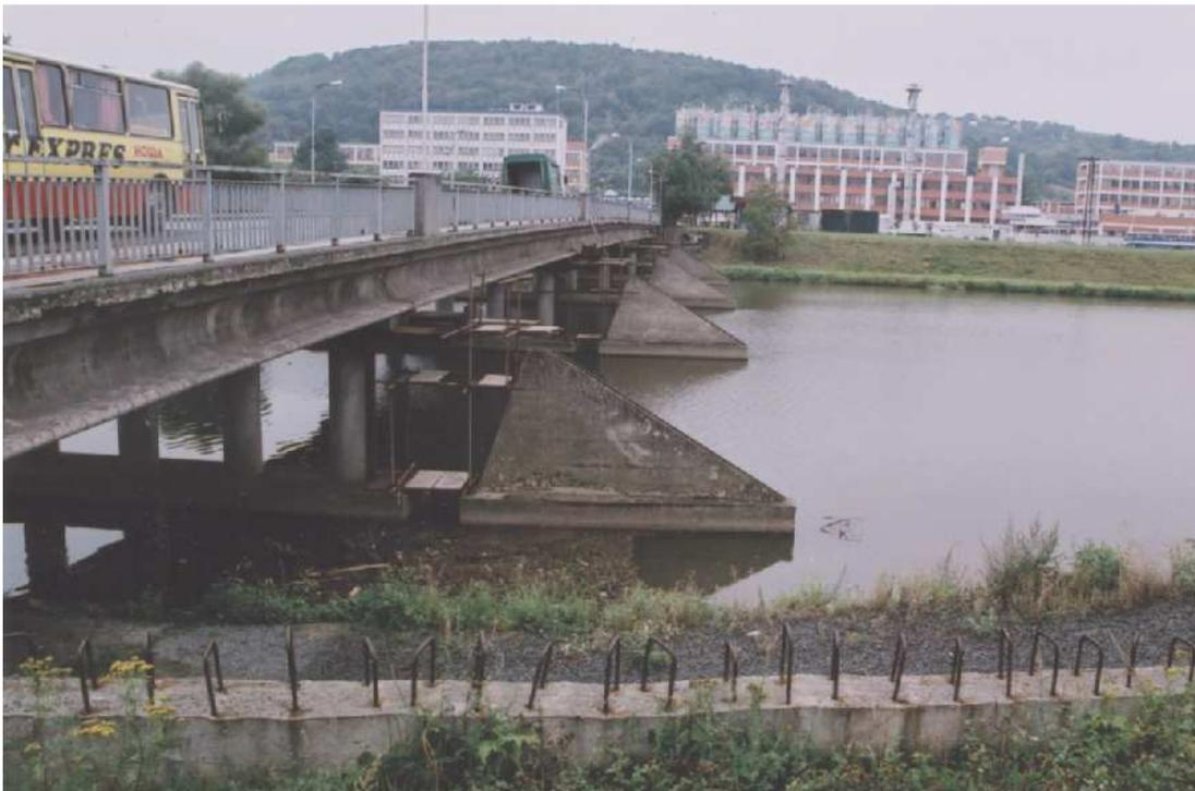
*Les piles des ponts doivent être protégées par des avant-becs contre les embâcles, les glaces – Pont de Napajeda sur la Morava (CZ)*
