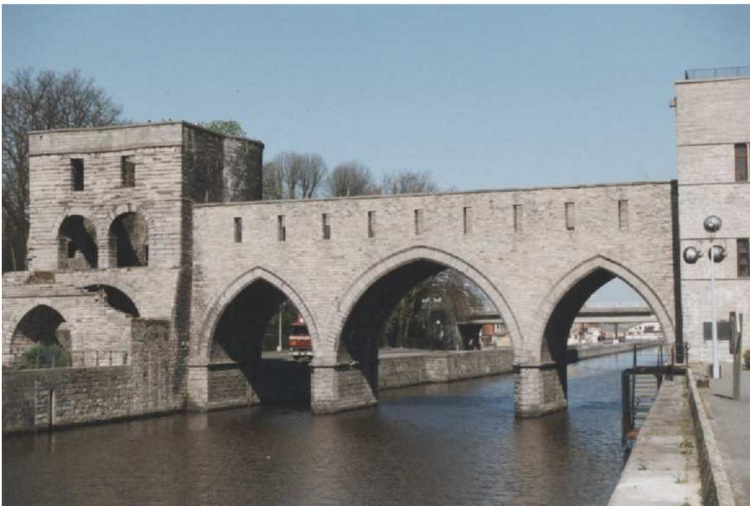
*Le pont des trous, à Tournai (B) Passe centrale surélevée de 2m40*
