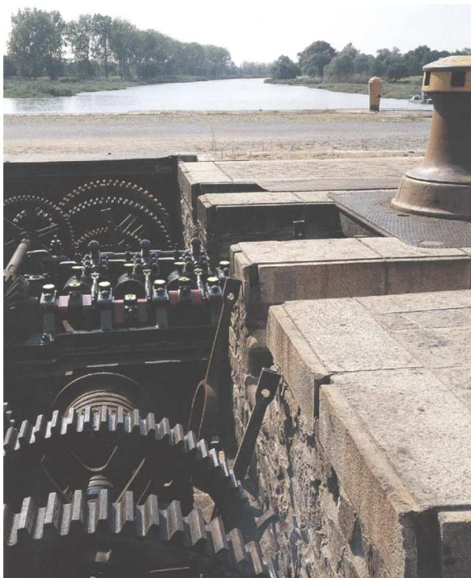
*Canal de la Martinière (F-44) mécanisme des portes*
