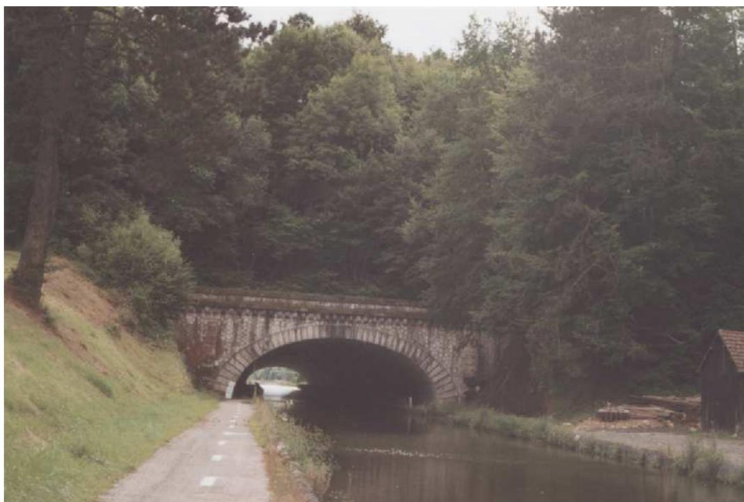
*Le souterrain ancien de Condes (F-52) sur le canal Champagne-Bourgogne est consolidé par une couche de béton armé. Pour ne pas gêner la navigation les travaux ont été effectués de nuit, à partir d'échafaudages flottants.*
